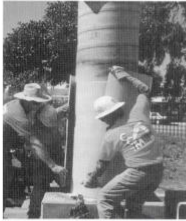
Figure II. 14. Chemisage par coquille préfabriquée « PRF ».[28]
