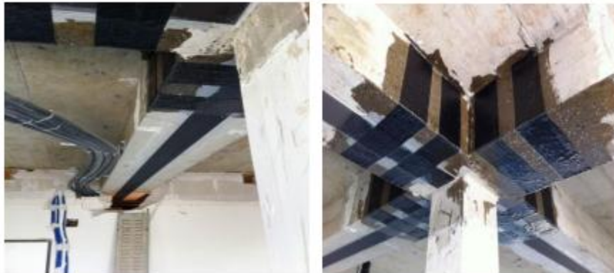
Figure II. 16. Poutres en BA renforcées par matériaux composites.
