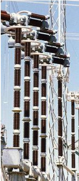
Les disjoncteurs à air comprimé ont supplanté les disjoncteurs à l'huile dans le domaine des hautes performances grâce à la haute rigidité diélectrique et aux bonnes propriétés thermiques du fluide utilisé. L'air comprimé sous une pression de 20 à 35 bars est évacué à l'intérieur de buses pour permettre d'obtenir un refroidissement efficace de l'air.
