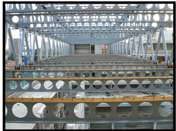
Figure : vue sur les poutres alvéolaires.
