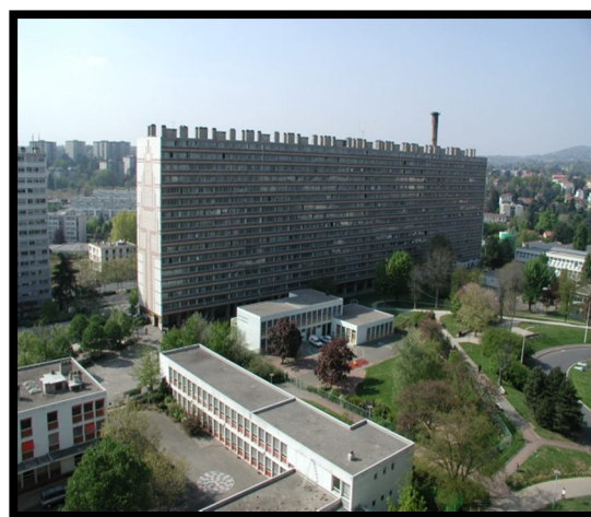
Figure : Immeuble "la Barre 200" à Lyon - La Duchère (69)
