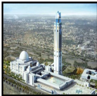
Figure : Réalisation de la grande mosquée
