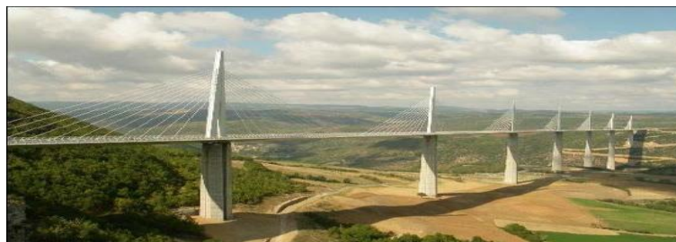
Figure II.2 : Pont à haubans
