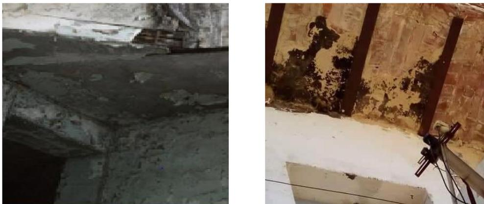
**Figure3.20 : Plancher en IPE et briques.**
