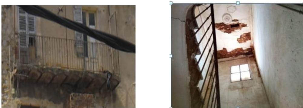
**Figure 3.8 : Etat des éléments non structuraux.**
