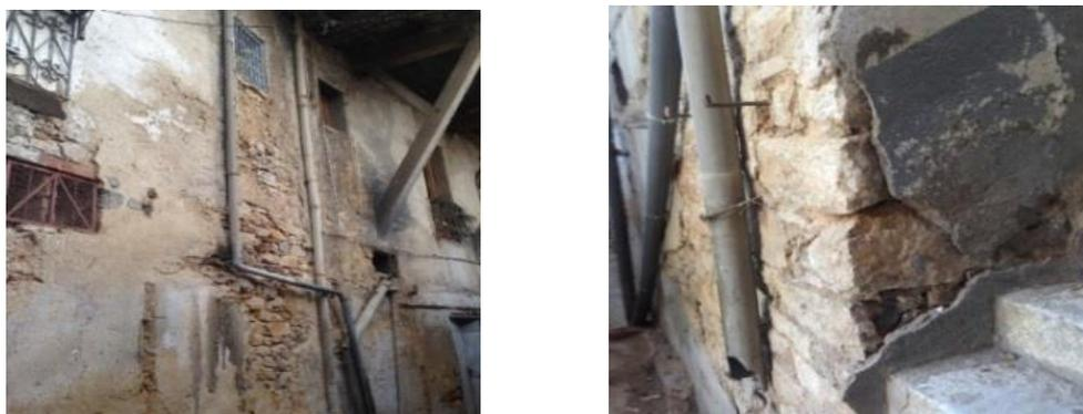
**Figure 3.11 : Erosions des mortiers et désolidarisation de la maçonnerie.**
