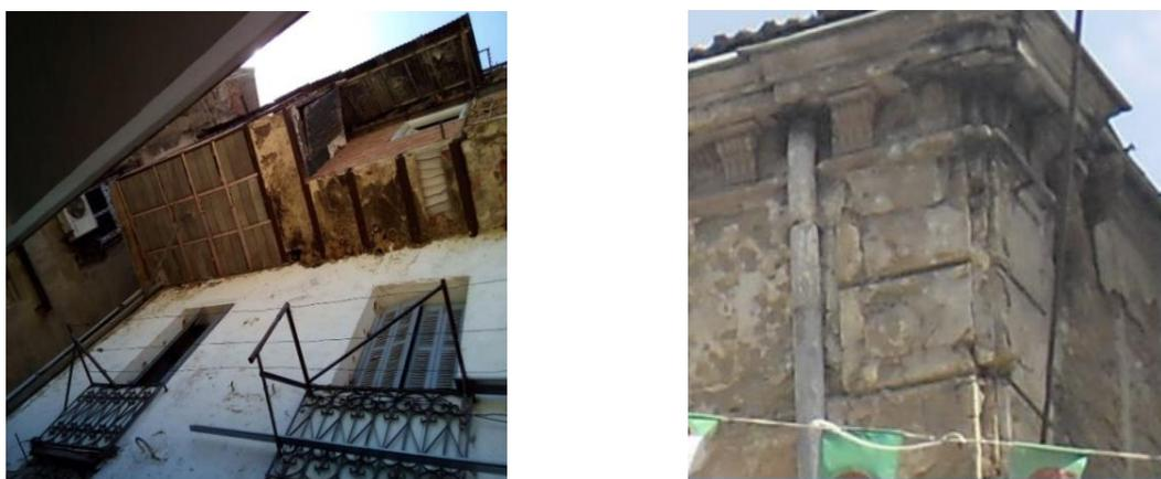
**Figure3.15 : dégradations d'éléments non structuraux.**
