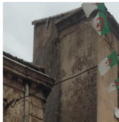
Figure3.18 : Dégradations des enduits.
