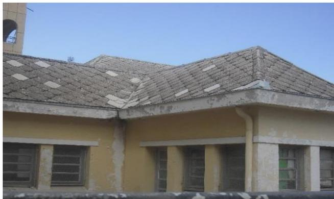
**Figure 3.48: Toiture en tuiles ardoise clouées.**
