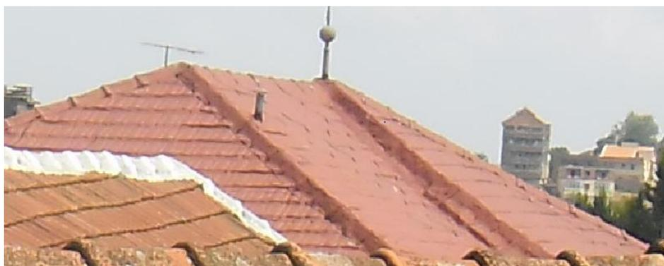
**Figure 3.42 : Toiture en tuiles plates.**
