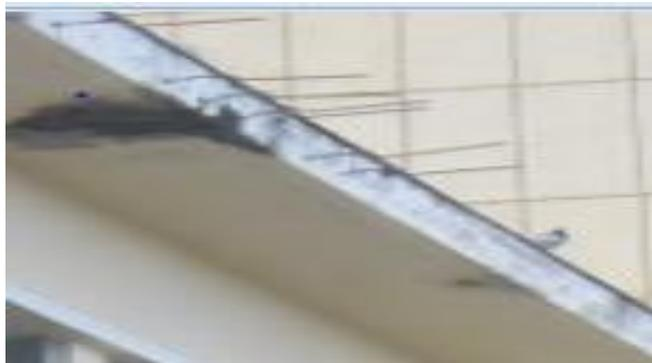
**Figure 3.47 : Plancher en dalle plein en bon état.**
