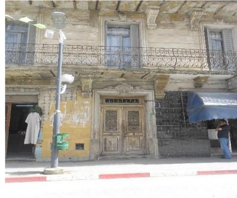
**Figure3.9: Dégradations du bâtiment.**
