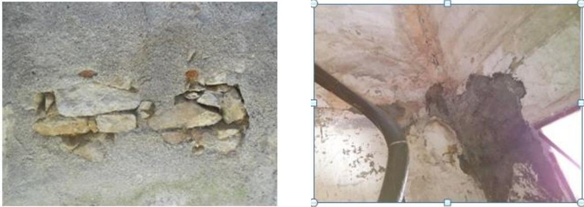
**Figure3.4 : Dégradations des enduits.**
