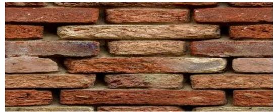
**Figure 2.8 : Erosion des mortiers.**
