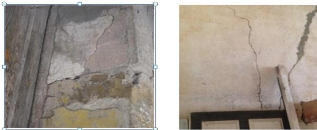
**Figure3.5: Fissures et désolidarisation de la maçonnerie.**
