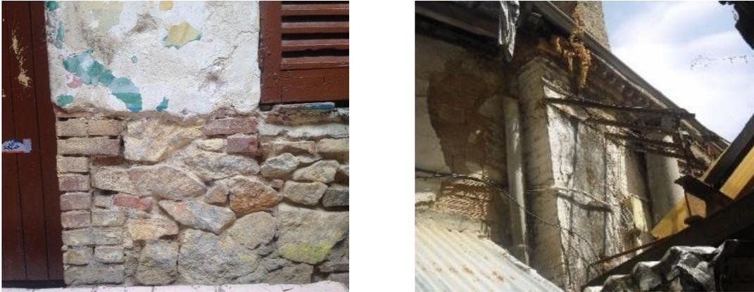
**Figure 3.33 : Dégradations d'enduits et désolidarisation des maçonneries.**
