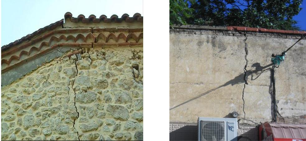
**Figure 2.13:Apparition des fissures sur les refends et murs porteurs.**
