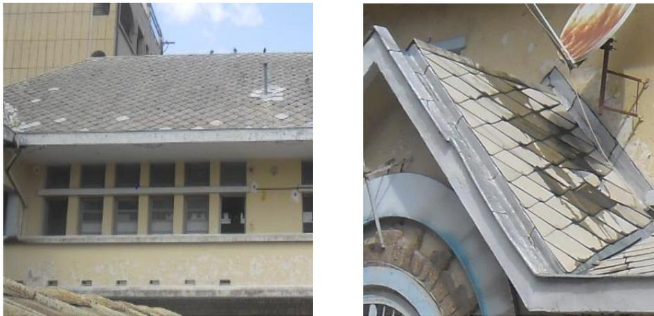
**Figure 2. 22 : Charpente en bois et ardoises clouées.**
