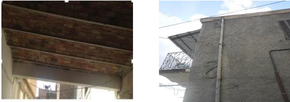
Figure 2.16 : Plancher rigide avec tirants métalliques bien connectés.
