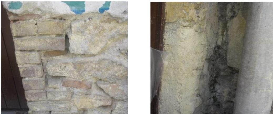
**Figure 3.32 : Erosion des mortiers.**
