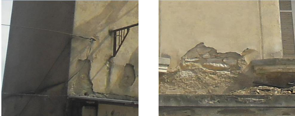
**Figure3.19 : Dégradations des enduits.**
