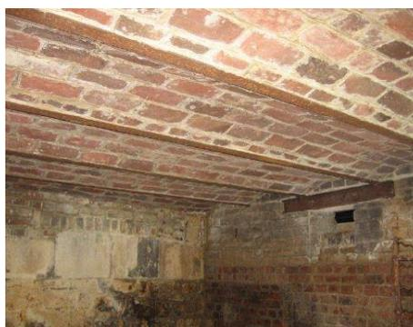
Figure 2.18 : Plancher en voutes mal connecté.
