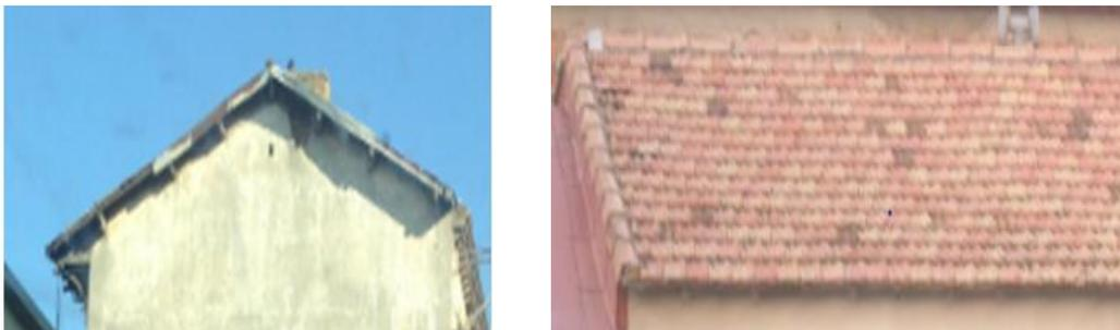
**Figure 3.7 : Toiture en tuiles plates.**
