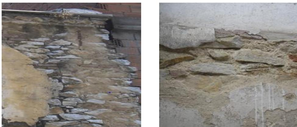
**Figure 3.12 : Maçonneries et points de connexion en mauvaise état.**
