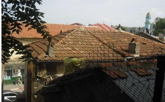
**Figure 3.35 : Toiture en tuiles plates.**
