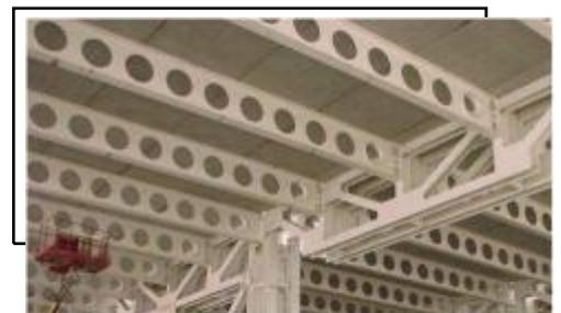
Figure 162: poutre alvéolaire
