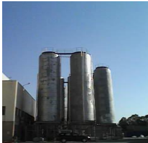
Figure 1-2 : Réservoirs de fermentation
