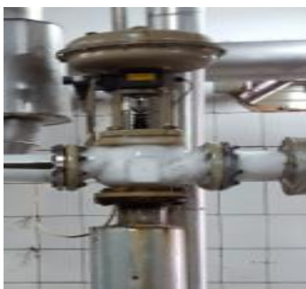
Figure 1-5 : vanne proportionnelle
