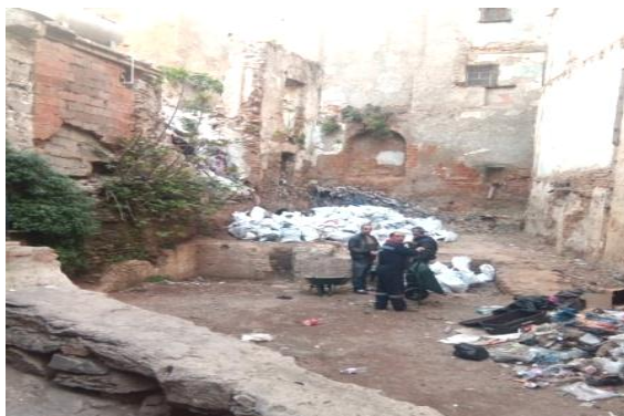
Figure 81 : Espace libre créé après la démolition d'une construction précédente Source : l'auteur
