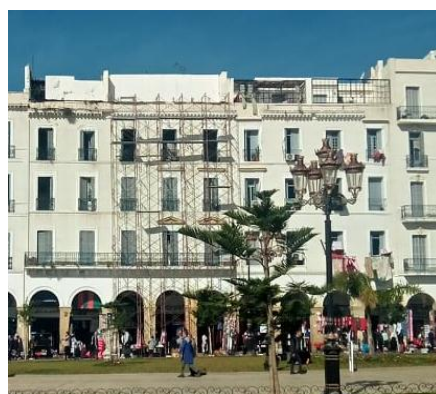
Travaux de restauration en cours.
