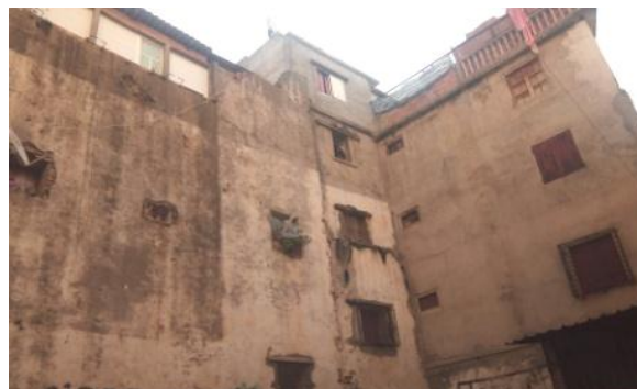
Figure 80 : Espace libre créé après la démolition d'une construction précédente Source : l'auteur
