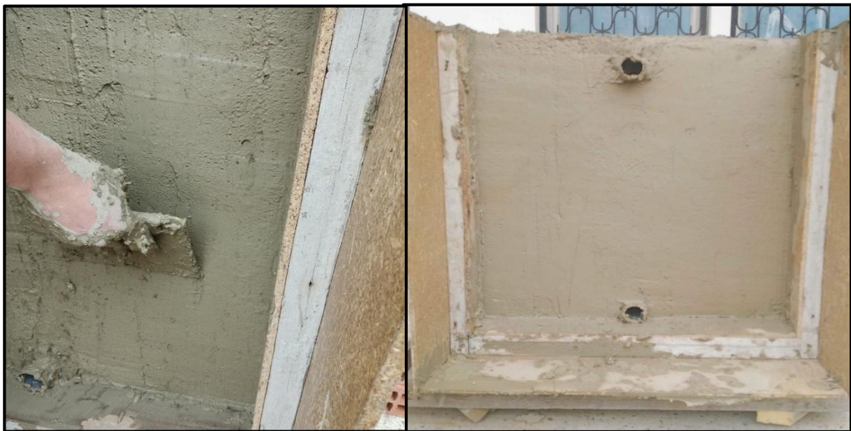
Figure I.12 : Etalage du mur
