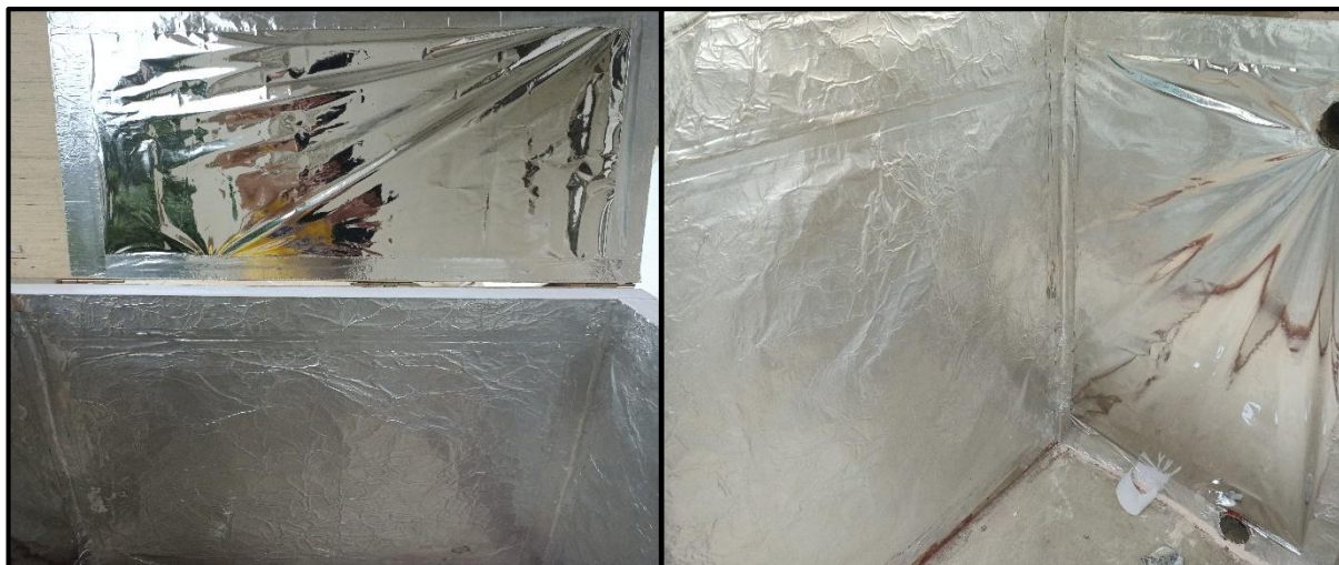
Figure I.14 : revêtement des parois intérieures avec des feuilles en aluminium
