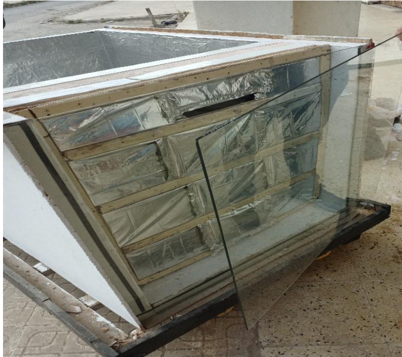
Figure I.17 : Mise en place du vitrage.
