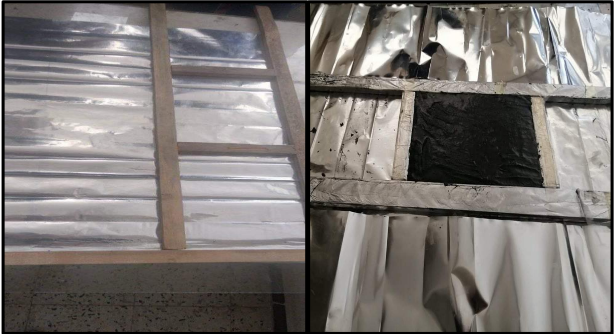
Figure I.9 : préparation du moule.
