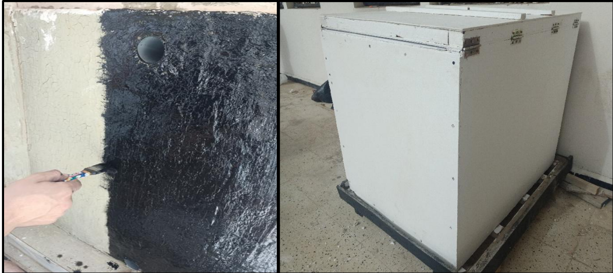
Figure I.13 : Peinture du mur argile et parois extérieures.
