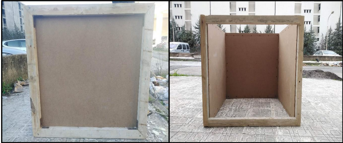
Figure I.1 : réalisation des parois en bois
