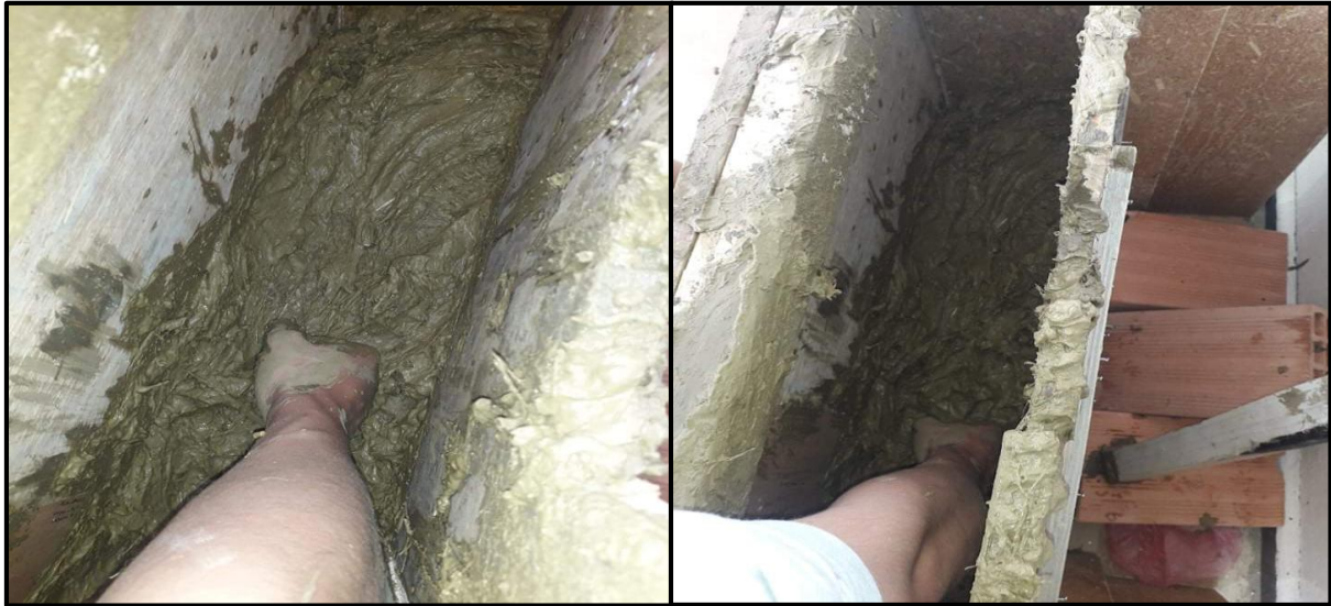
Figure I.9 : remplissage du moule
