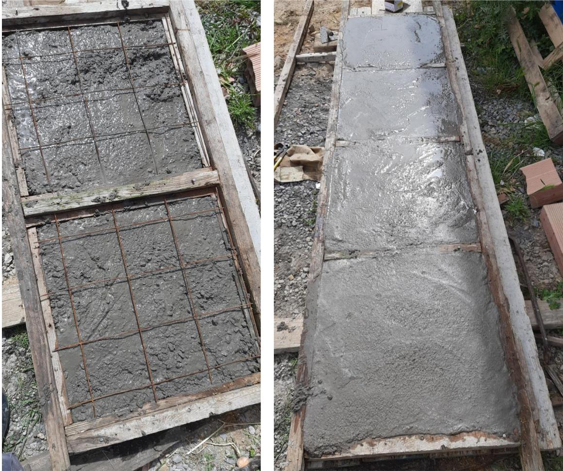
**Figure III.5:** remplir les moules par le béton.
