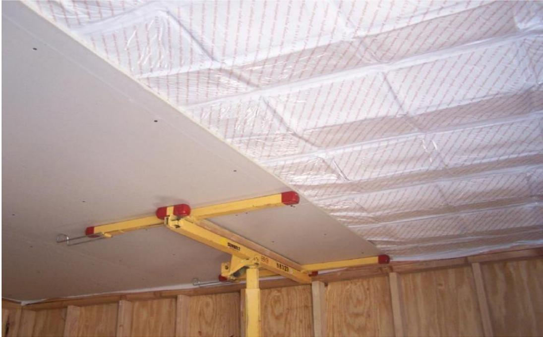
**Figure II.5:** Applications passives de systèmes de plafond amélioré par MCP
