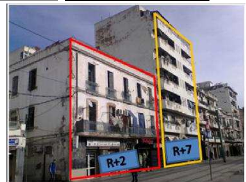
Figure 30 : Image des immeubles sur Tripoli
