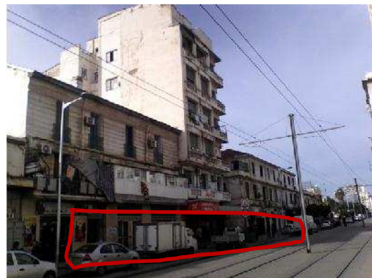
Figure 24 : Image de la rue Tripoli Source : Auteur
