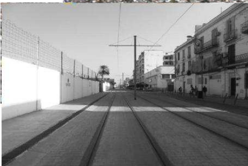
Figure 55 : Image de la rue Tripoli Source : Post-graduation 2013/2014 La requalification de la rue Tripoli Hussein Dey
