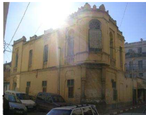
Figure 107 : Image d'une habitation Source : Auteur
