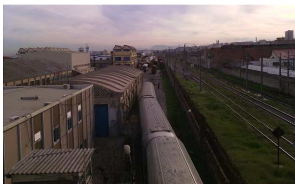
Figure 139 : État des lieux du chemin de fer Source : Auteur
