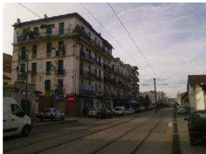
Figure 38: Image de la paroi Sud-Ouest de Tripoli Source : Auteur
