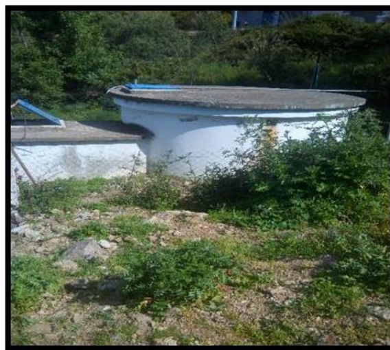
Figure (III.8) : Vue extérieur du réservoir de Charaioua
