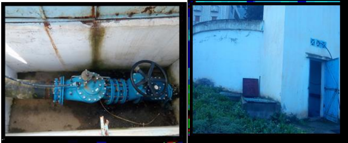
Figure (III.2) : Vue extérieure du réservoir de la SR1 et la chambre de vanne
