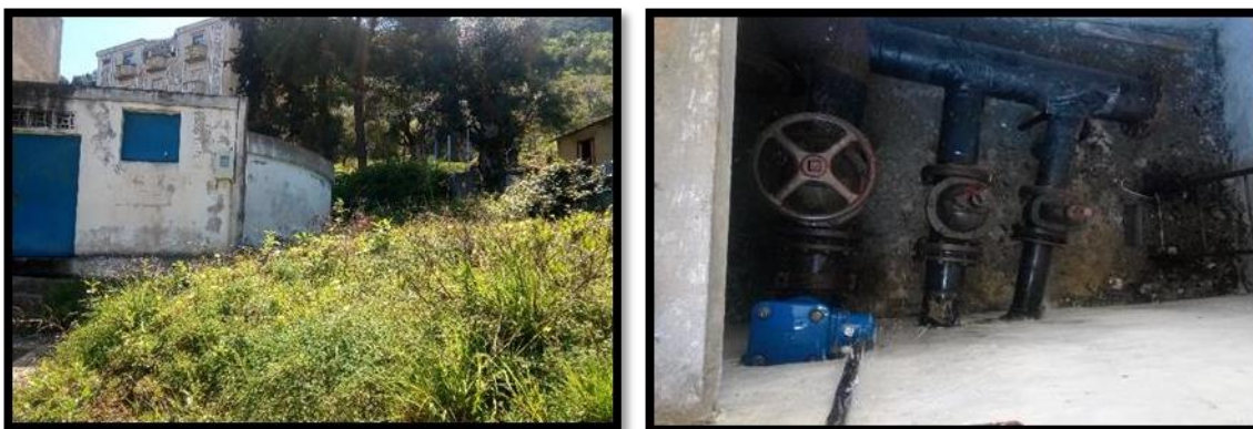
Figure (III.4) : Vue extérieure du réservoir d'Ikhríben et la chambre de vanne
