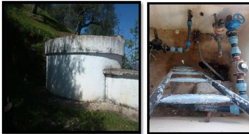
Figure (III.10) : Vue extérieure du réservoir d'Amalou et la chambre de vanne
