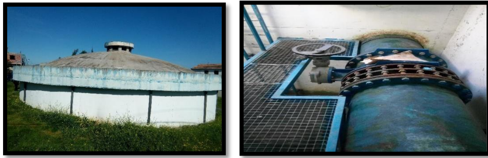
Figure (III.1) : Réservoir de Tazazrait et la chambre de vanne
