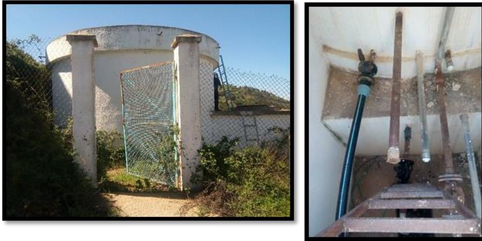
Figure (III.5) : Vue extérieure du réservoir d’Afensou et la chambre de vanne
