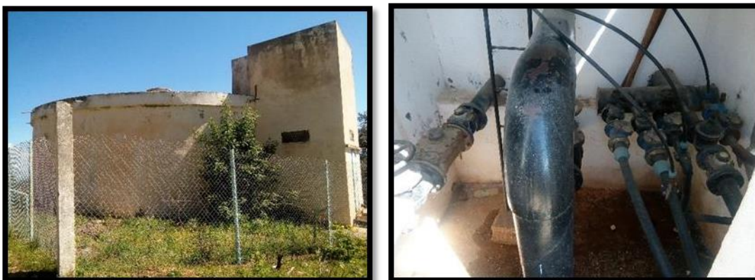
Figure (III.6) : Vue extérieure du réservoir de Belias et la chambre de vanne
