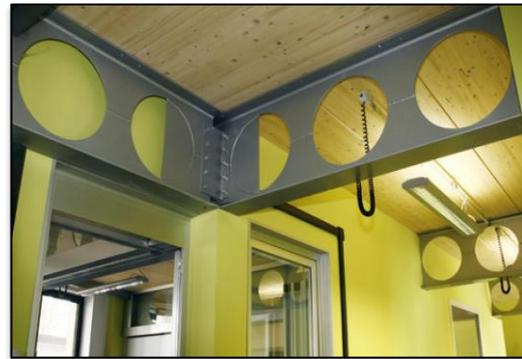
**Figure 197 :** les poutres alvéolaires.
