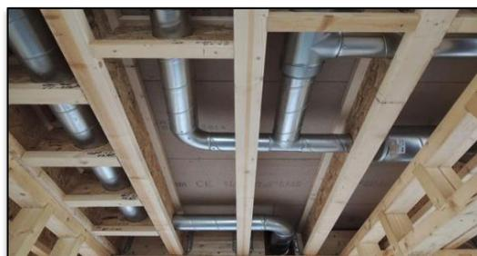
**Figure 257 :** gains techniques dans le plafond
