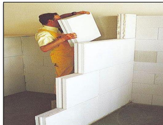
**Figure 244 :** Cloison fixe béton cellulaire.
