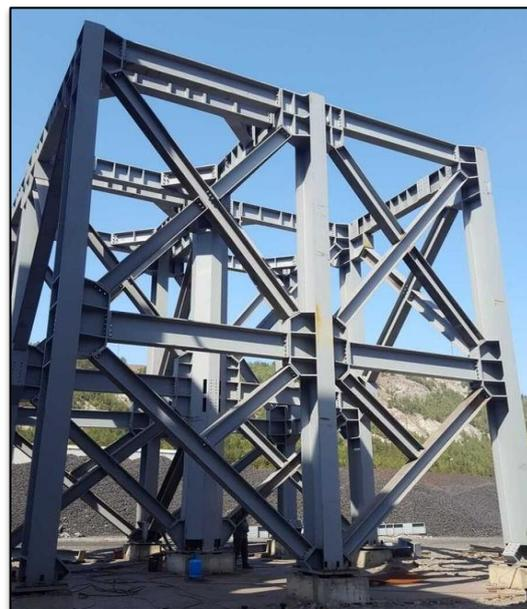
**Figure 214:** contreventement d'une structure
