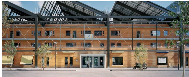
Photo 51 : Photo après la réhabilitation. (Source : https://www.jourda-architectes.com/projets/hall-pajol/ )
