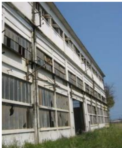
Photo 19 : : Façade EST du bloc C. (Source : Bouaziz Samia, mémoire de magister).
