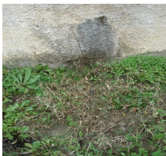
Figure 1.4 : Fuite sur la paroi du réservoir.
