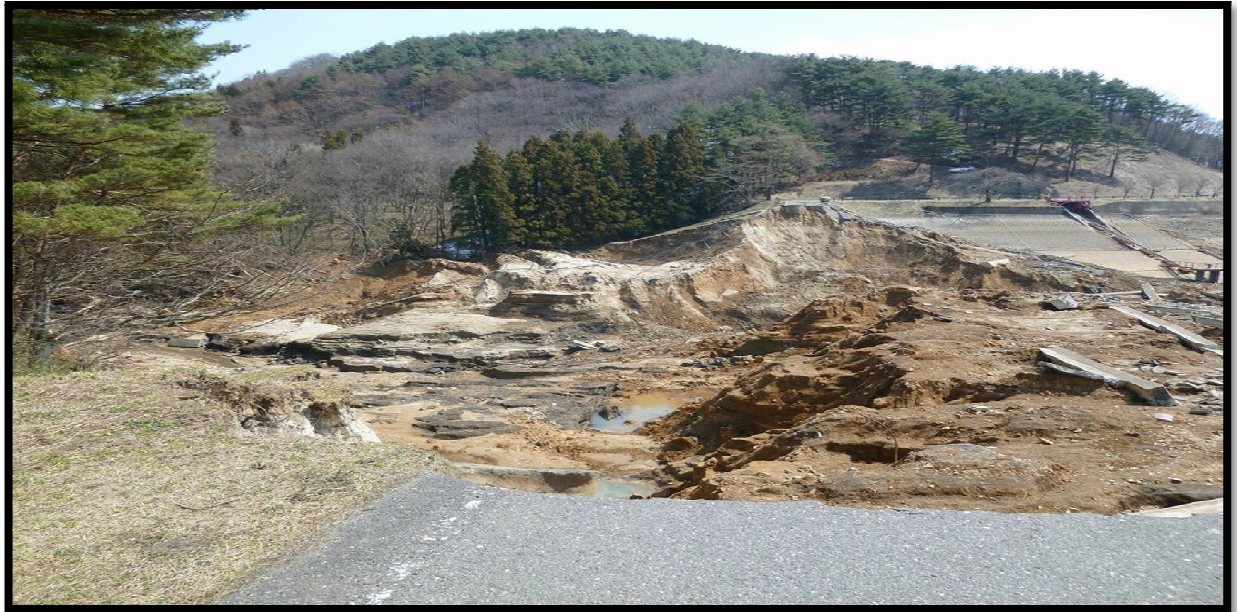
Figure III- 8 : Rupture du barrage de Fujinuma (séisme de Tohoku mars 2011).
