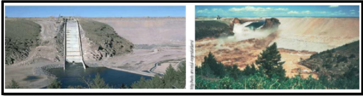
Figure II-7 : Vue sur le barrage de Teton (USA) avant et après rupture
