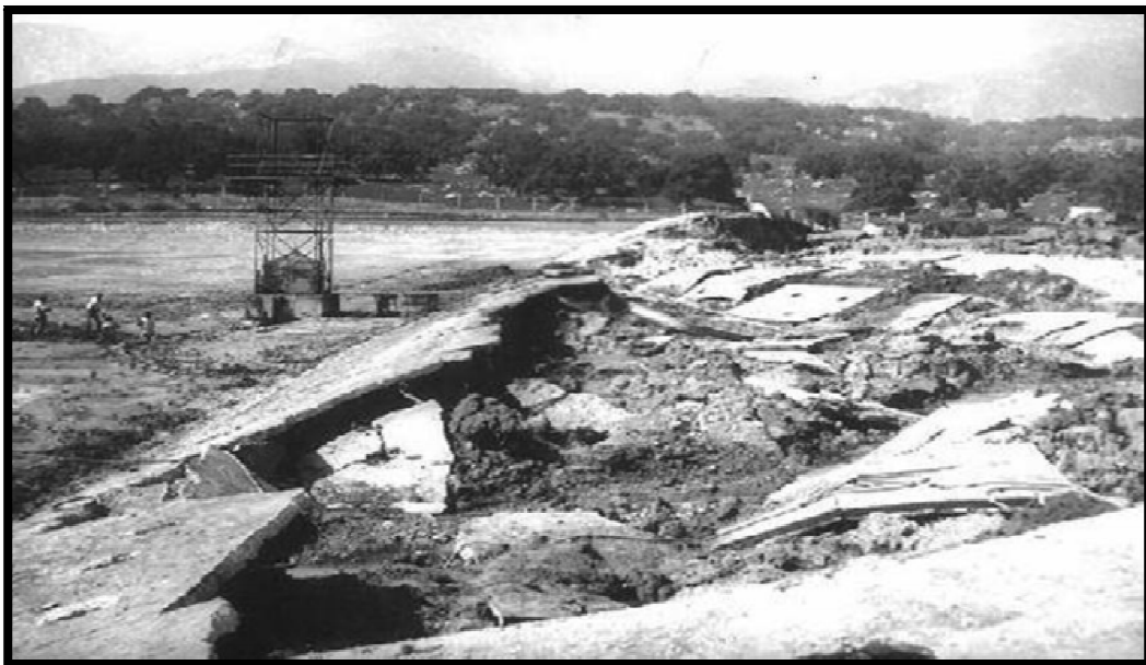
Figure III- 9 : Rupture du barrage de Sheffield de Santa Barbara.
