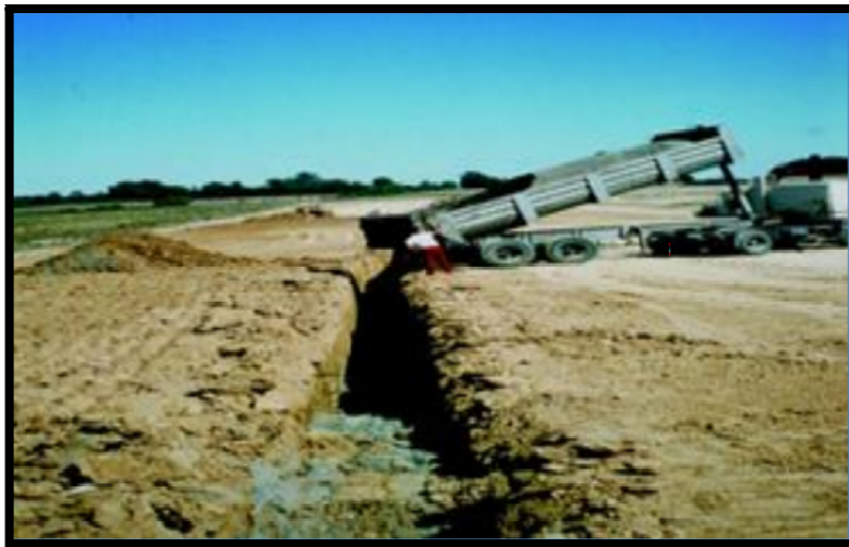
Figure I-11: Drain vertical recreusé dans le remblai
