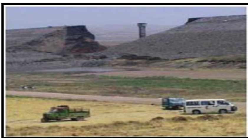
Figure II-9: Barrage de Zeyzoun après sa rupture
