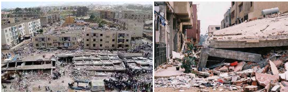
Figure VI- 2: Dégâts provoqués par le séisme de Boumerdes en 2003.
