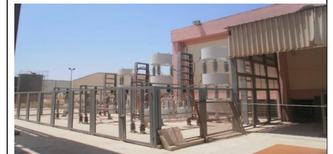
Transformateur 10 MVA pour l'électrolyse
