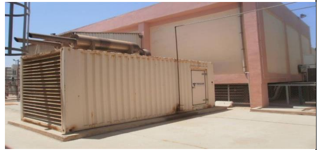
Groupe électrogène 800 KVA TEKSAN
