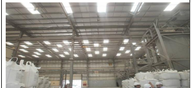
Unité silicate : Hangar HTP : Revêtement intérieur inflammable
