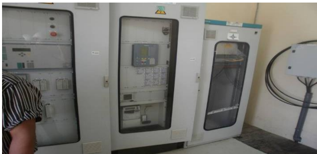
Salle d'armoire du transformateur 30 MVA Partie commande, meure et protection
