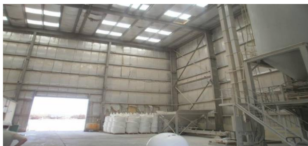
Unité silicate : Hangar de broyage du sable : Revêtement intérieur inflammable
