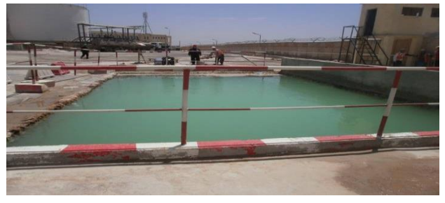
Fosse de rétention des eaux pluviales
