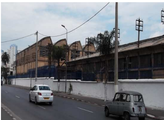
Figure 61 : Anciens Hangars fermés en état de vétusté
