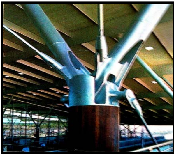
Figure 86 :Pièce moulée pour les poteaux d'une gare TGV Source: Concevoir et construire en acier Marc Landowski et Bertrand Lemoine
