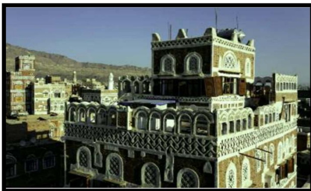
Figure16 : Les tours de Sanaa au Yémen
