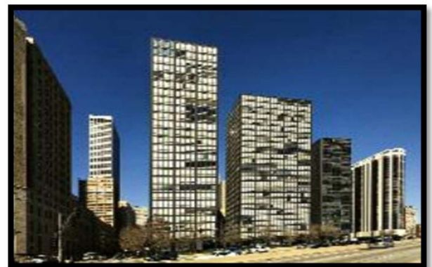
Figure17: l'immeuble de Lake Shore Drive de Mies van der Rohe
