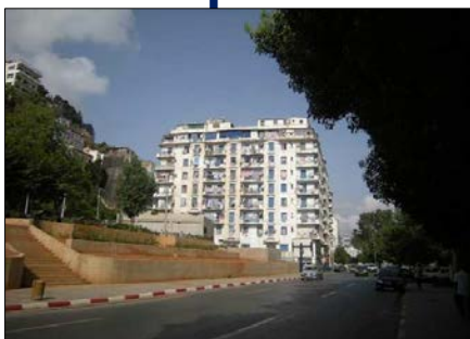
Figure 44 : vue sur le boulevard MOHAMMED BELOUIZDAD
