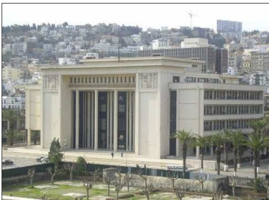
Figure 59 : Bâtiment type Moderne - Siège UGTA
