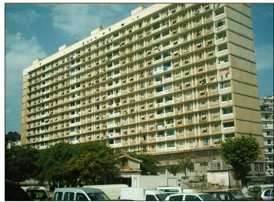
Figure 60 : Bâtiment type H.B.M
