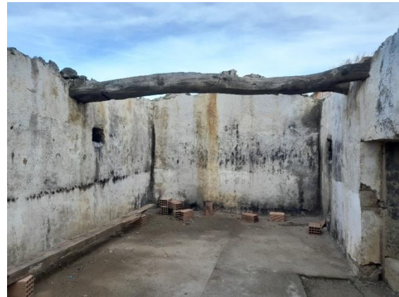
Photo n°8 Vue de l'intérieur
