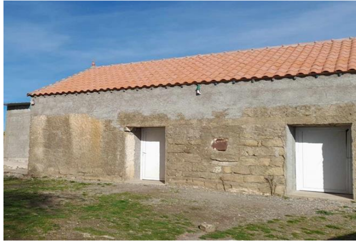
Photo n°13 Djamaa Ajdid vue de l'extérieur
