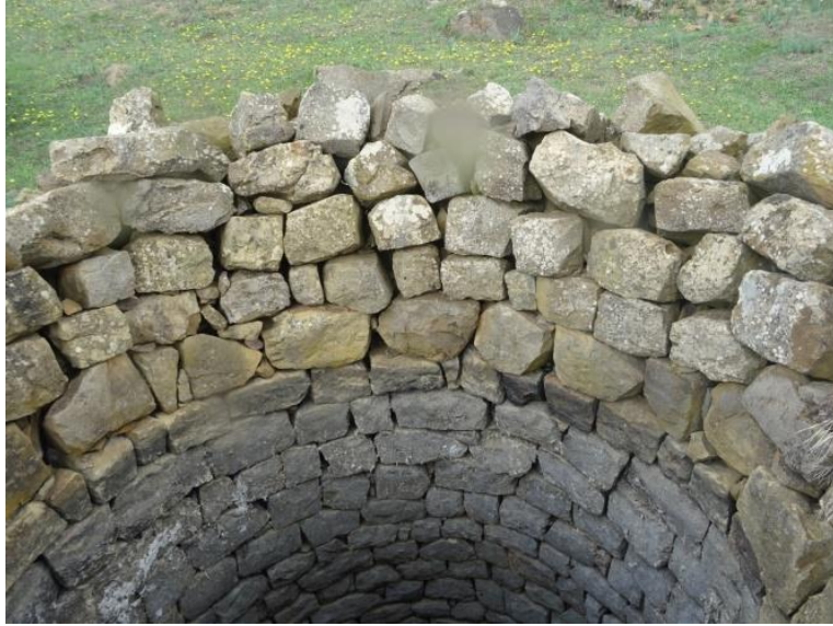
Photos n° 28:Le puit après sa restauration
