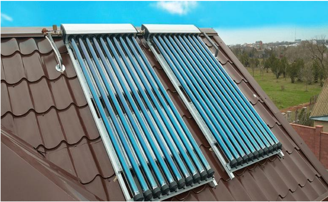
Figure I-18. Panneaux solaire thermiques [23]
