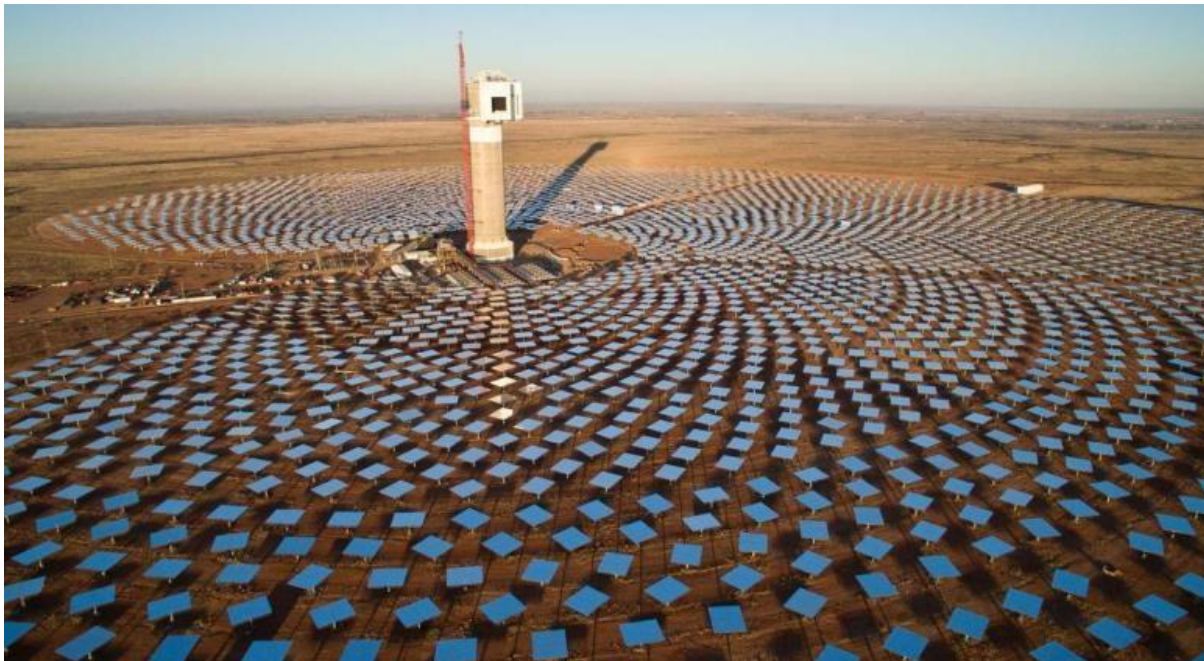
Figure I-24. La Centrale solaire à tour [30].
