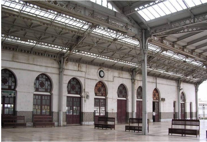
Fig. 03 : Halle de la gare d'Oran (1908-1913) Conjugaison style néo mauresque et architecture industrielle.
