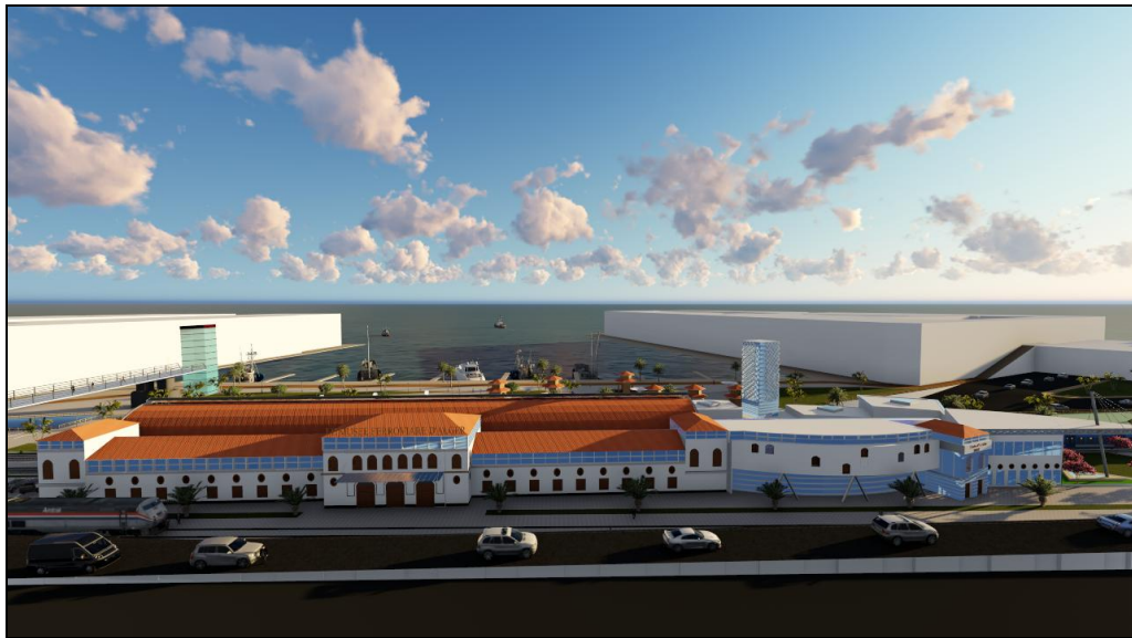
BV après réhabilitation
