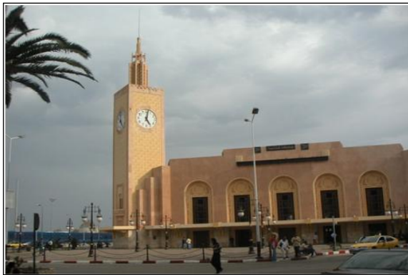
Fig. 07 : La gare ferroviaire d'Annaba. Source : https://annaba-patrimoine.com .
