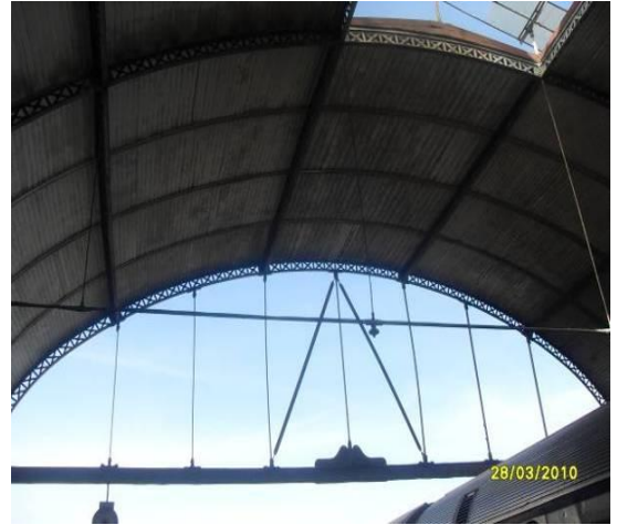
Fig. 04: Halle de la gare d'Alger. [Source : Photo personnelle]
