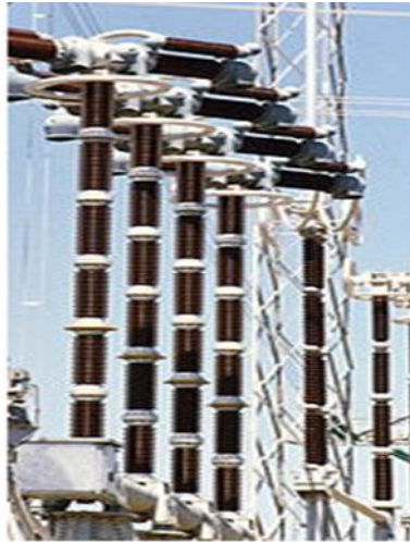
Fig. (III.11) : disjoncteur a air comprimé
