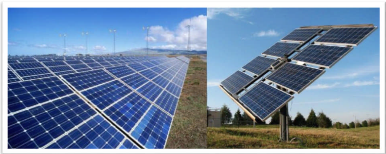
Fig (I.11) : Panneau photovoltaïque. [1]
