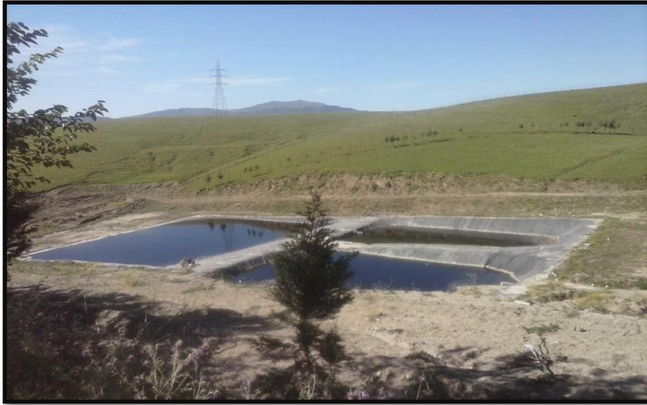
**Figure 14:** Bassins de rétention des lixiviats (Photo originel).
