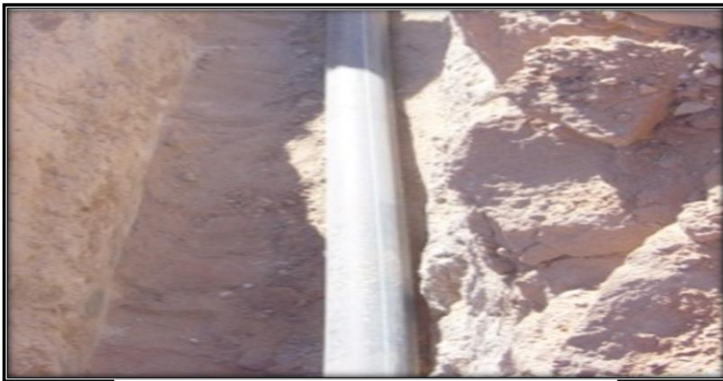
Figure V.1. Pose des conduites en terre
