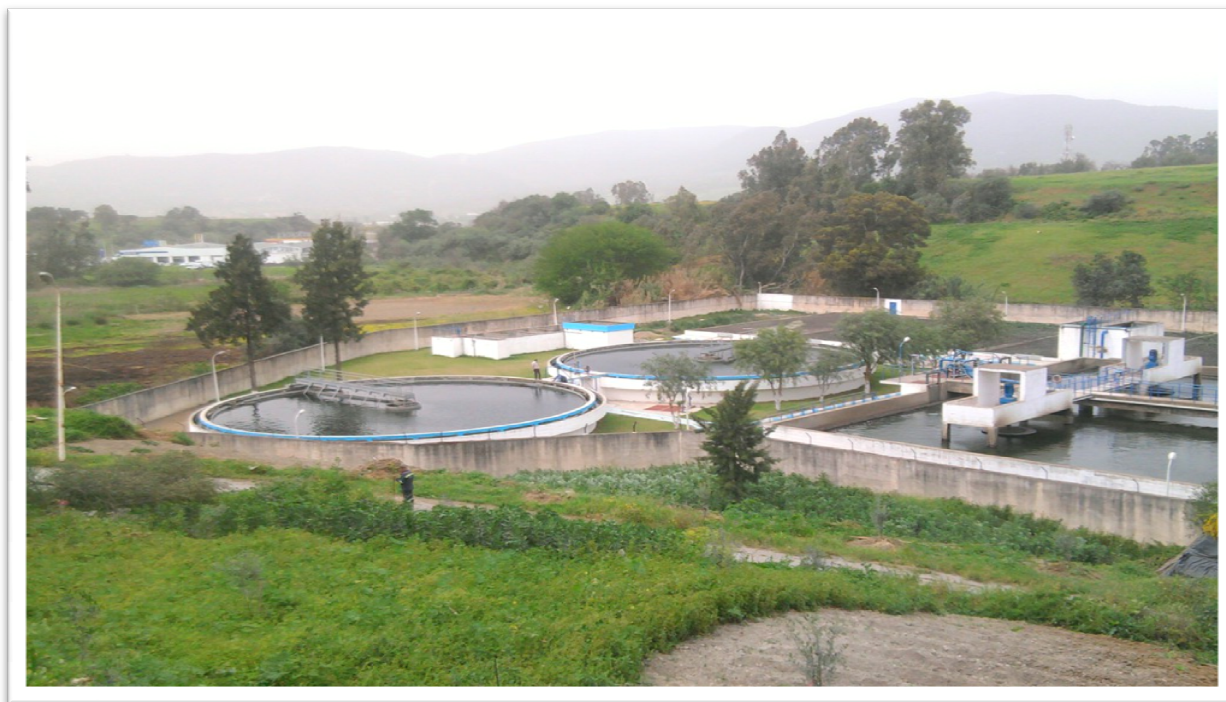
Figure (7) : Vue générale de la STEP Ouest Boukhalfa
