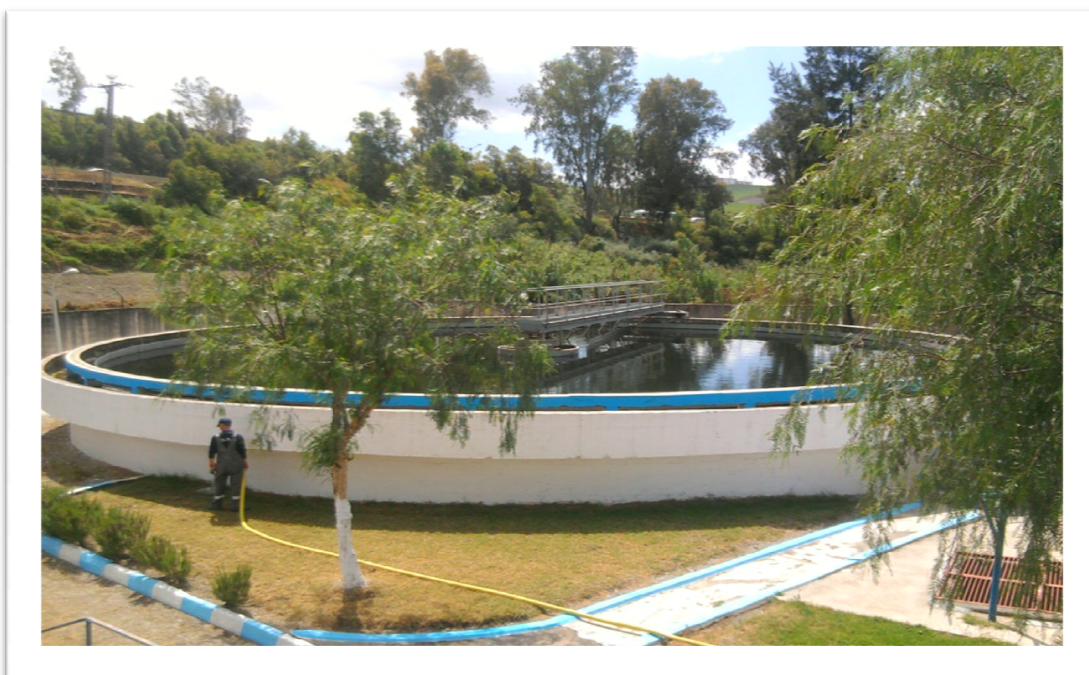
Figure(18) : bassin de clarification
