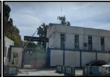
Figure 30 : unité travaux publique Source : auteurs
