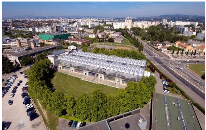
Figure 127 : ens d'architecture de Lyon source : Google
