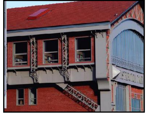
Figure 94 : La charpente réparée de la halle
