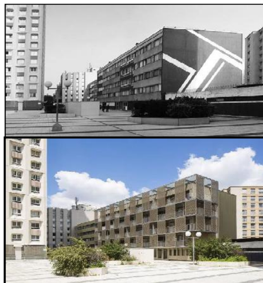
Figure 5 : Réhabilitation des logements sociaux du square vitruve source : Google
