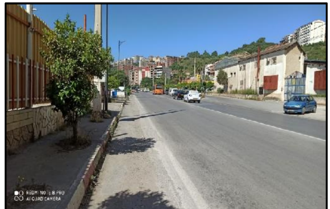
Figure 54 : avenue CHABANE AHCENE tronçon B Source : auteurs
