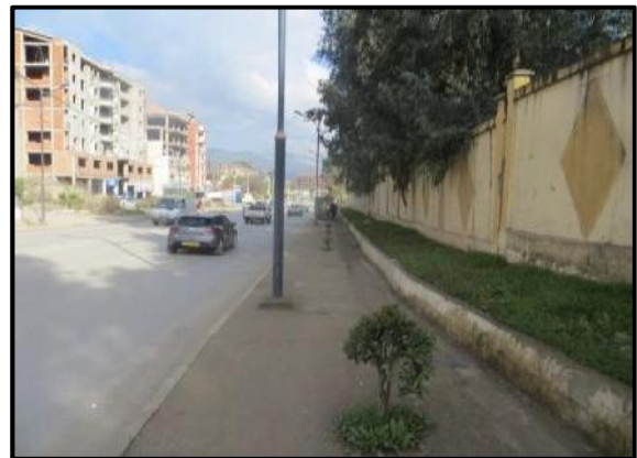
Figure 78 : façade aveugle Source : auteurs
