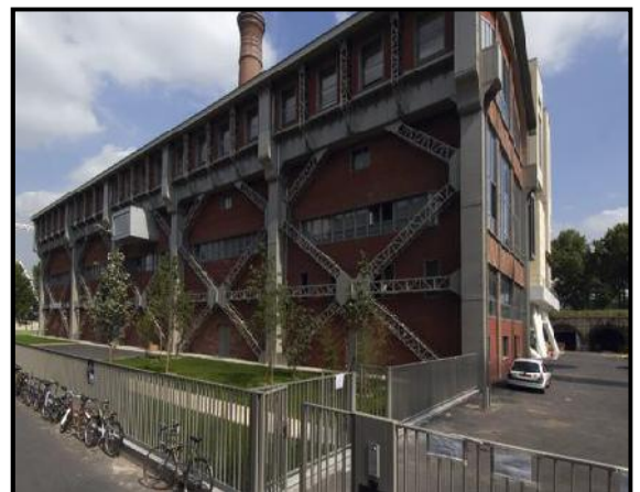
Figure 96 : Vue sur la halle après sa réhabilitation
