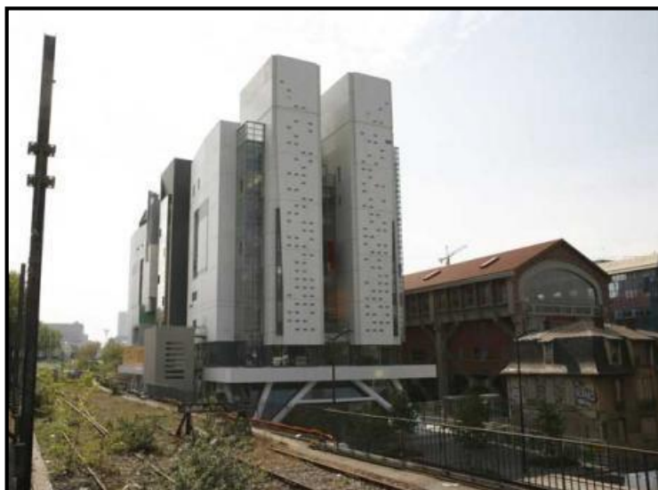
Figure 99 : l'extension de l'école du val de seine source : www.paris-valdeseine.archi.fr
