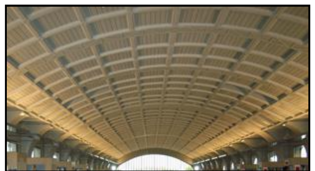
Figure 93 : La charpente réparée de la halle Source : www.brudieuxfranck.com
