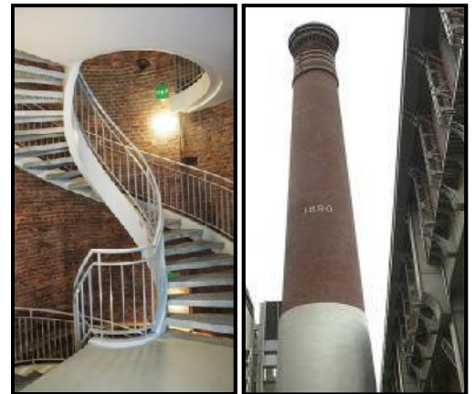
Figure 95 : l'intérieur de la cheminée après sa réhabilitation.
