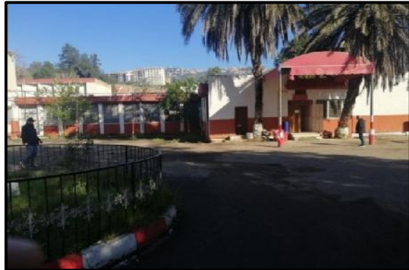
Figure 36 : Dégradation du département d'architecture Source : auteurs
