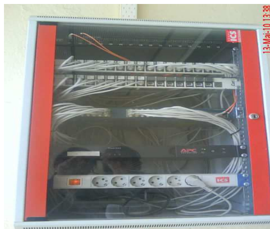
Fig. III.5 L'armoire de brassage
