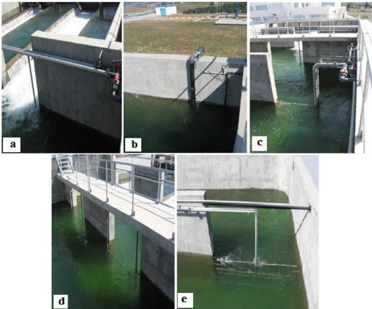
Figure I.2 : Différentes injections des produits chimiques
