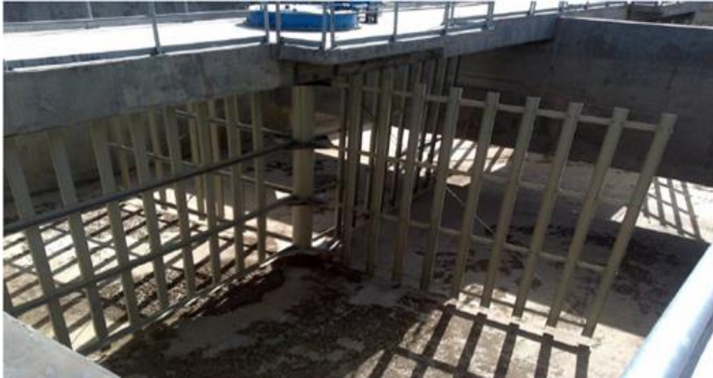
Figure I.4 : Flocculateur rotatif a barrières.
