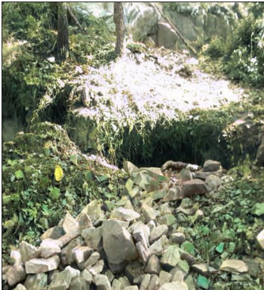
Figure 29. Crevasse provoquée par l'extraction de pierres
