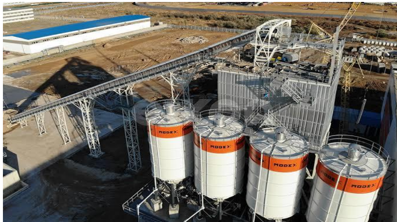
Figure I-01: Centrale à béton type tour.
