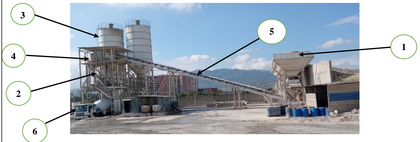
Figure II- 01: Centrale à béton POWERMIX 90.
