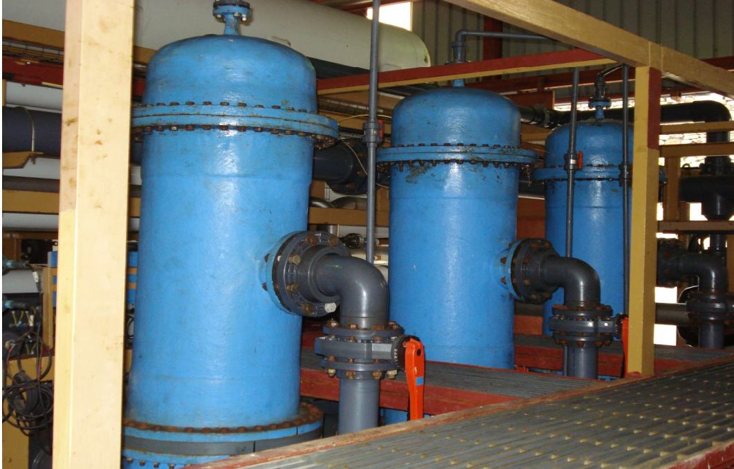
Figure II.4 :Unité de filtres d'affinage
