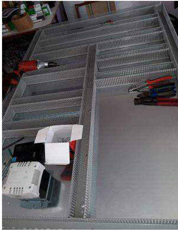
Figure III-5 : Insertion des goulottes
