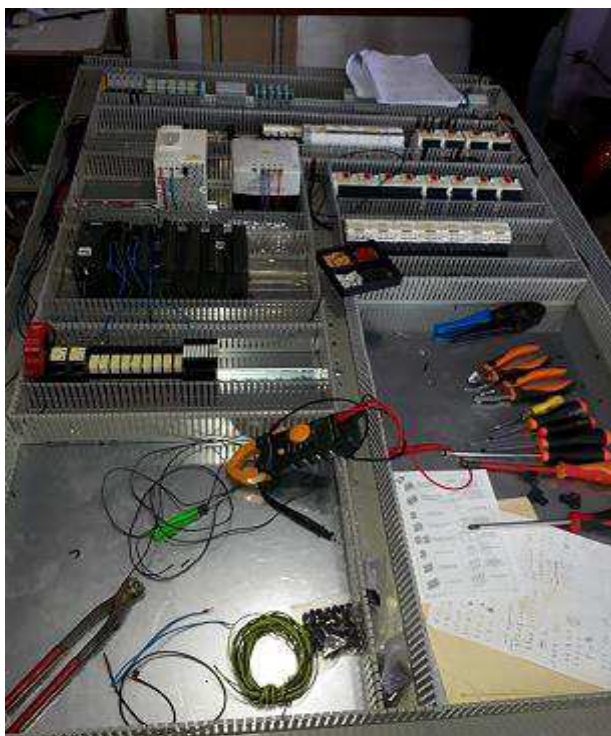
Figure III-6 : Début de câblage
