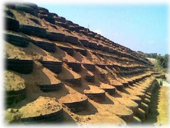
Figure III.10. Chantier expérimental pneusol à Bousmail
