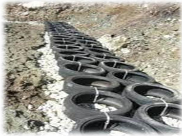
Figure III.9. Réalisation d'un mur de soutènement à Bejaia
