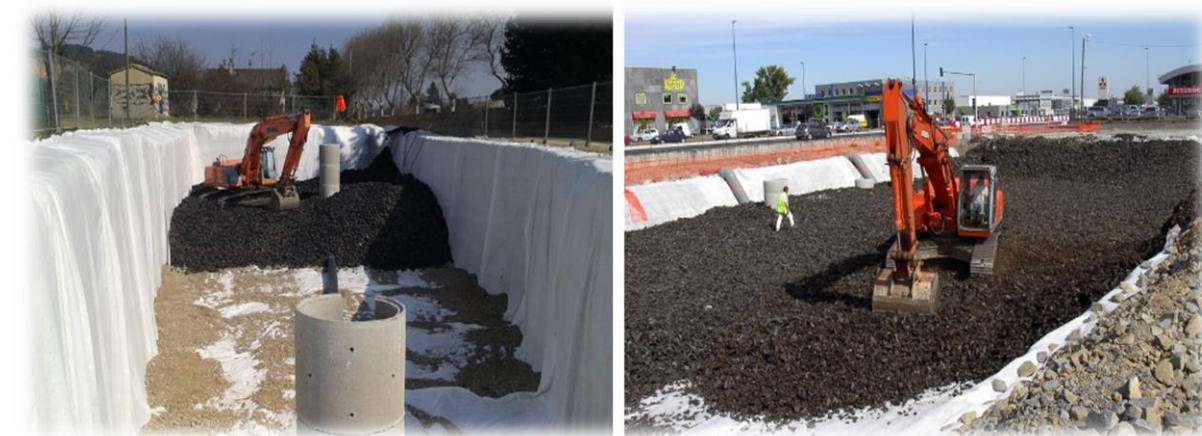
Figure III.12. Réalisation d'un bassin de rétention
