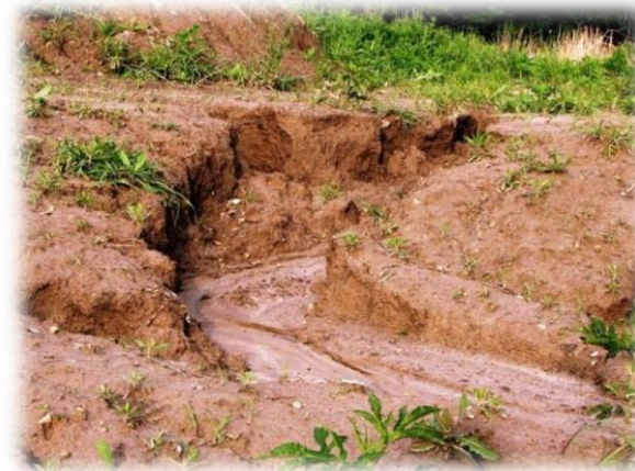
Figure I.19. Érosion de sol
