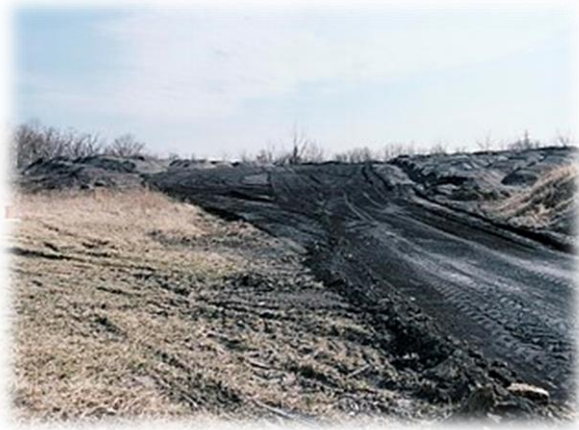
Figure II.8. Application des cendres volantes sur une route
