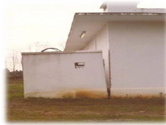
Figure I.18. Tassement différentiel
