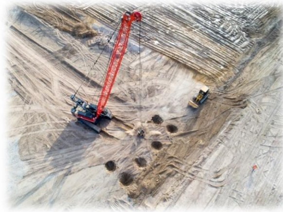
Figure II.1. Compactage dynamique d'un sol
