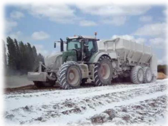
Figure II.6. Épandage de la chaux
