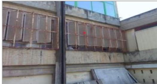
Figure II. 36 : Modèle de l'ancienne brise soleil
