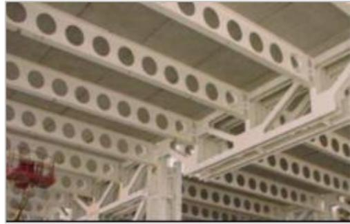
Figure 31 : Poutre alvéolaire
