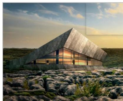
Figure I. 44 : Exemples de façades en bardage stratifié HPL
