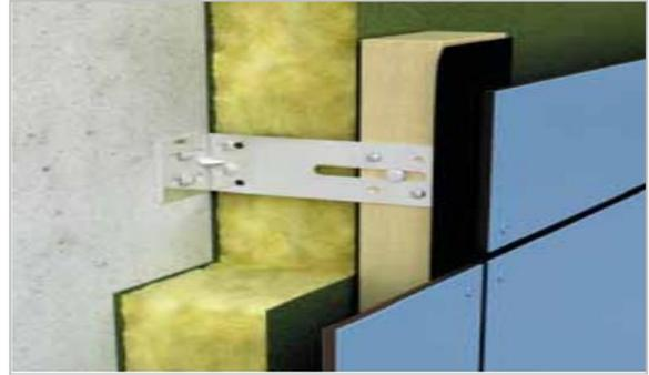
Figure I. 43 : Fixation sur ossature métallique
