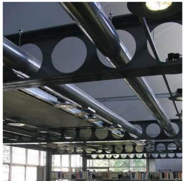
Figure 124:poutre métalliques alvéolaires Source : http://www.archiexpo.fr/fabricant-architecture-design/poutre-alveolee-8275.html
