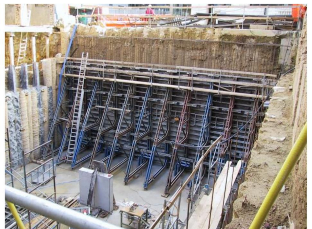
Figure 122:Mise en œuvre de voiles périphériques/ Source : www.wolftech.be
