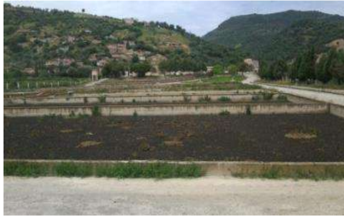
Figure n°10 : Lits de séchage.
