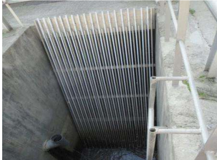
Figure n° 05 : Dégrilleur grossier.
