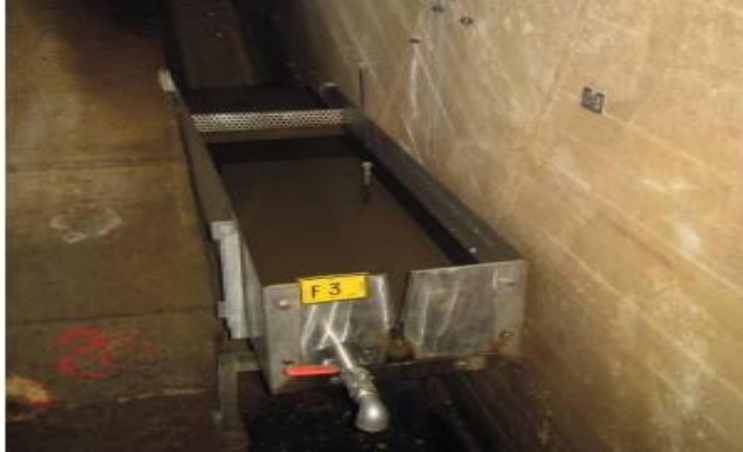
Figure I.26: vue d'un déversoir
