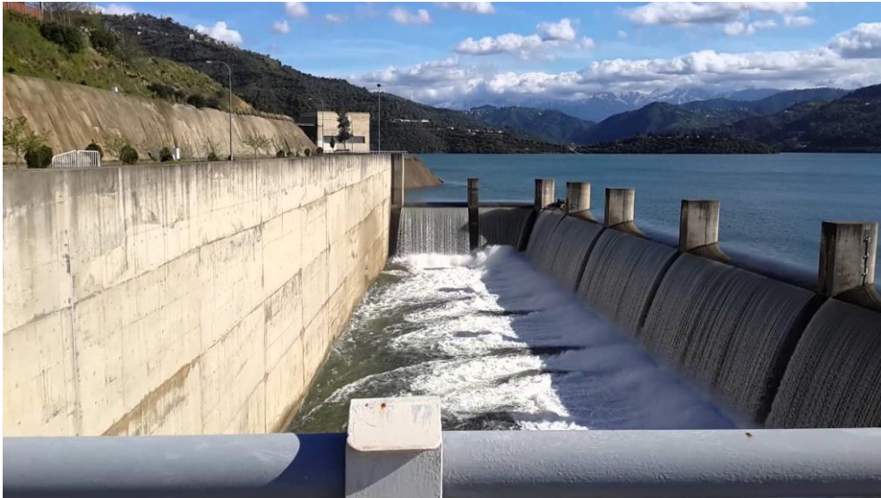
Figure I.4 : Vue de l'évacuateur de crue
