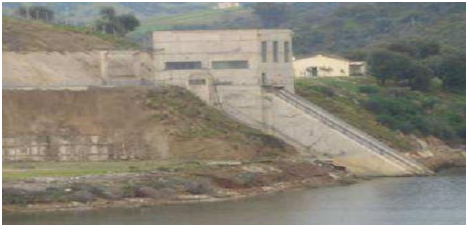
Figure I.2 : Station de prise d'eau du barrage Taksebt
