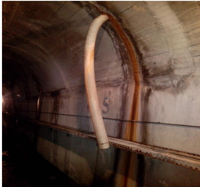
Figure I.25: photo d'un drain au niveau de barrage Taksebt
