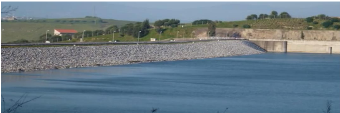
Figure I.3 : Vue de la digue de barrage Taksebt
