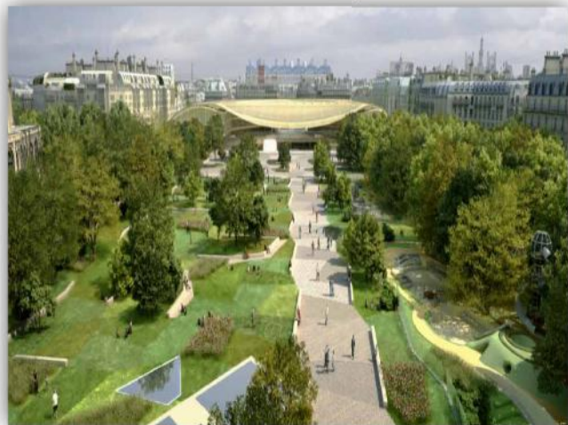
FIGURE 26: Vue extérieure des halles
