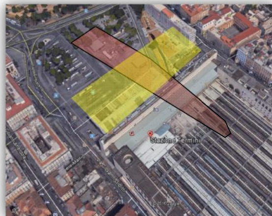
FIGURE 104 : VUE AERIENNE DU BATIMENT DE LA GARE
