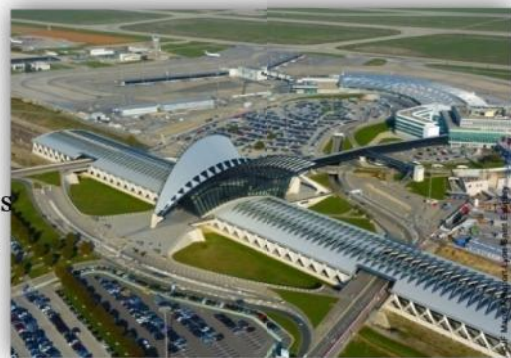
FIGURE 1: Gare ferroviaire de Lyon Saint Exupéry
