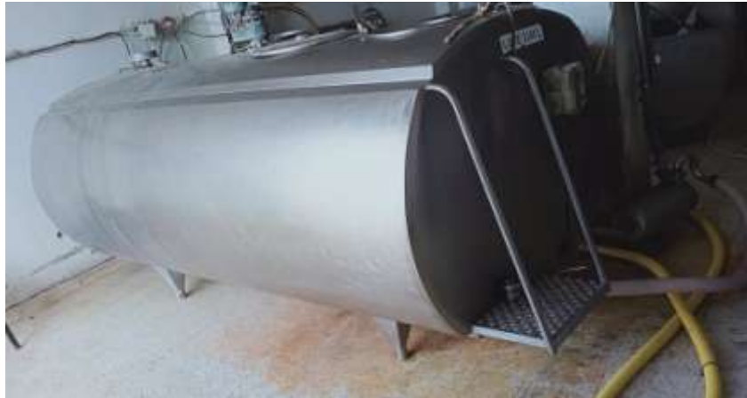
Figure 18 : cuve principale à filtre (3300L)
