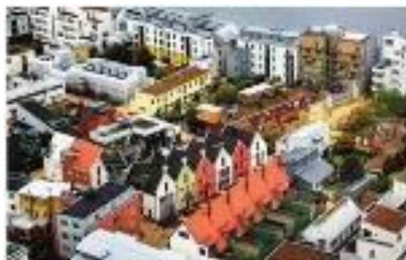
Figure 19 : des maisons en bande avec charpente Source : PDF quartier urbain à l'échelle humaine
