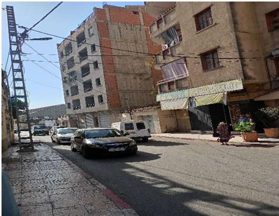
Figure 78 vue en perspective avant l'intervention. Source auteurs
