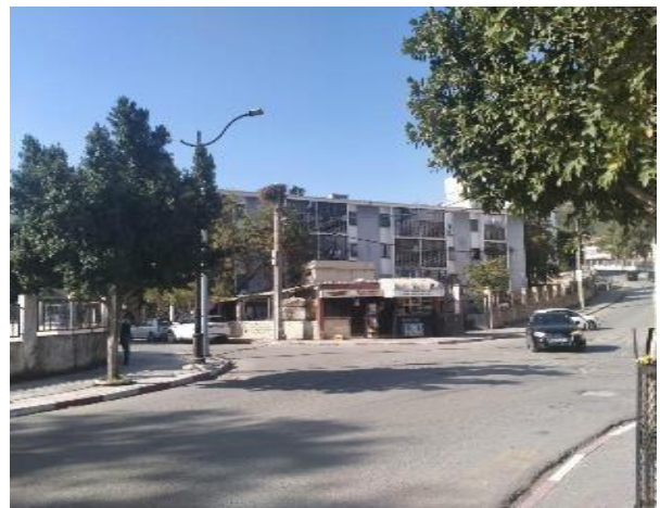
Figure 55 :vue en perspective avant intervention source auteurs
