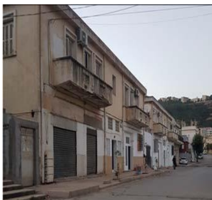
Figure 107 : Maisons individuelles Source : auteur
