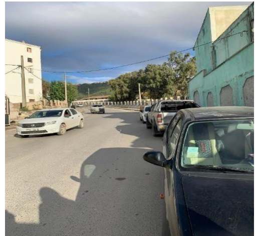
Figure 42 : Vue en perspective avant intervention Source : auteurs
