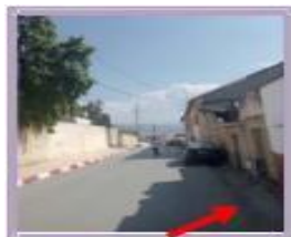
Figure 138 : Absence de trottoir Source : auteur
