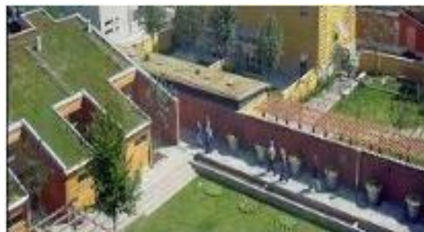
Figure 21 : toiture inclinées Source : PDF quartier urbain à l'échelle humaine
