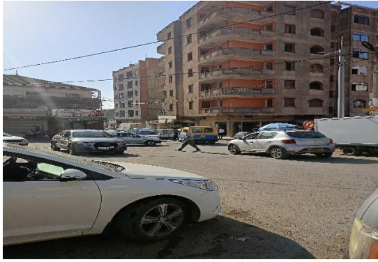
Figure 76: vue en perspective avant l'intervention. Source auteurs
