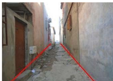
Figure 103 Ruelle desservant la cité ZRABA
