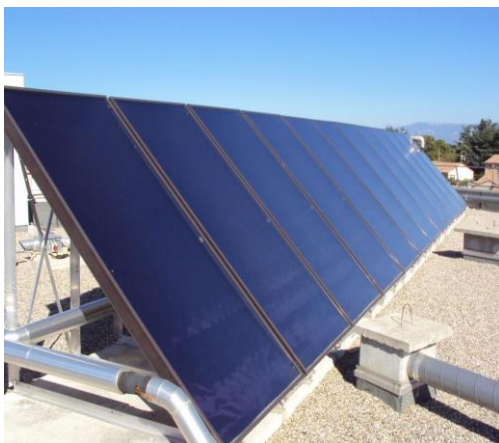
Figure. I.14 : Les panneaux solaires thermiques. Figure. I.15 : Fonctionnement des panneaux solaires thermiques.
