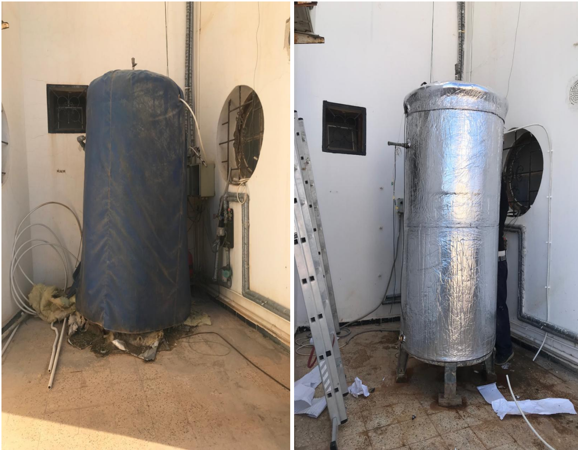
Figure.V.7: l'isolation thermique de la cuve de stockage avant et après le début des travaux.
