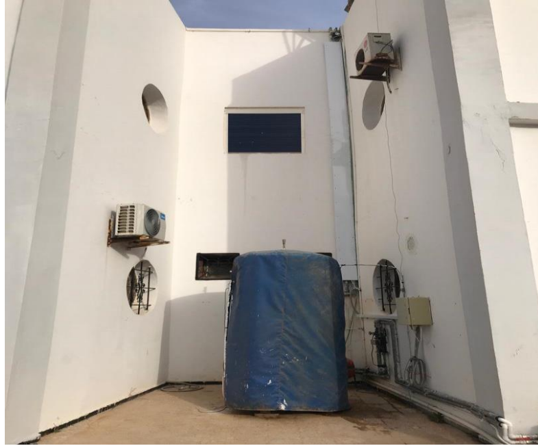
Figure. V.4 : Système de stockage.
