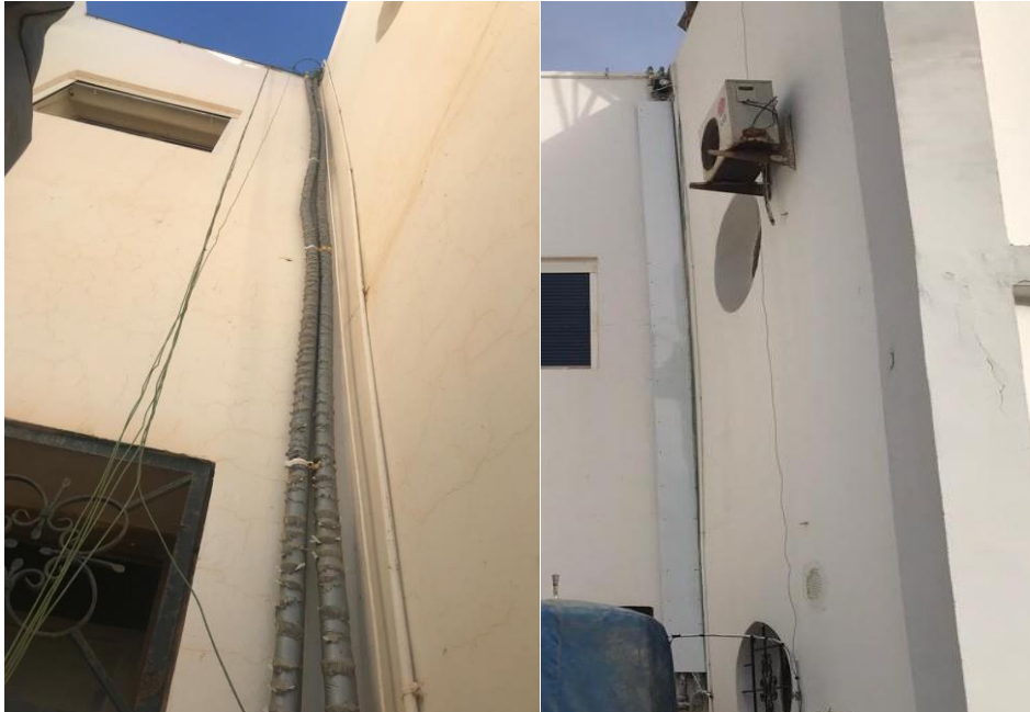
Figure.V.14 : La mise en place des différents thermocouples
