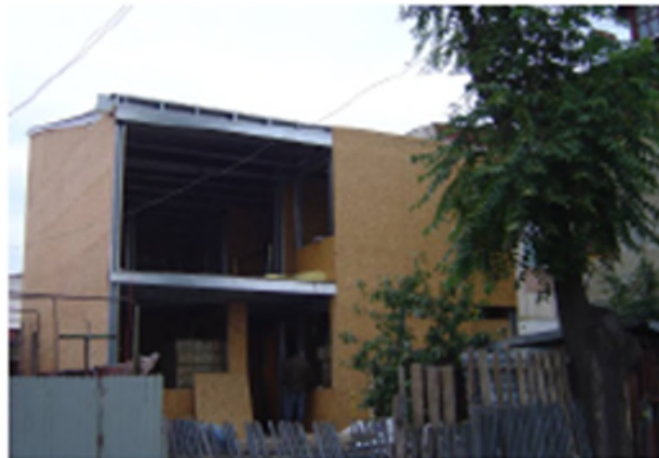
(b) Ossature métallique avec tous les panneaux OSB porteurs montés
