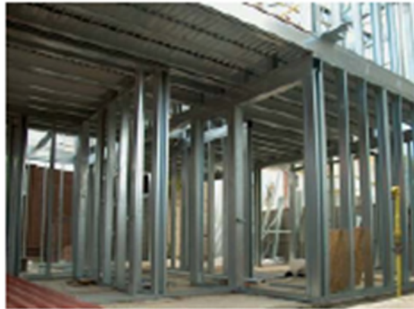
(a) Ossature métallique finie
