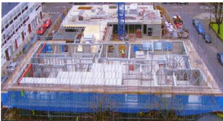
Figure 4-14: Bâtiment à usage mixte avec ossature légère en acier sur une structure intermédiaire en béton
