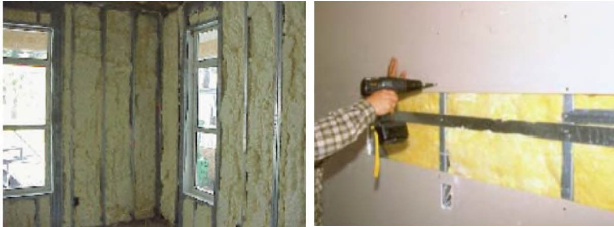
Figure 2-12: Introduction de la mousse isolante entre les panneaux de murs
