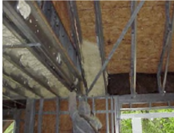
Figure 2-16: Isolation thermique et phonique sous plancher
