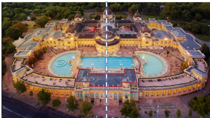
Fig. 3.59. Façade secondaire Source. Zoltan Gabor / Alamy Banque D'Images traité par Auteurs
