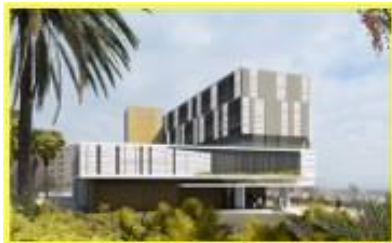
Fig. 3.29. Bloc administratif Source. Wikimedia Commons
