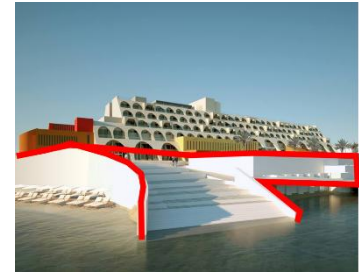
Fig. 3.18. Escalier de projet vers la mer Source. Algeria Invest.com traiter par Auteurs
