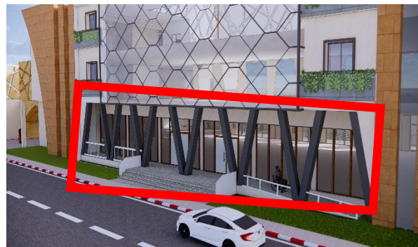
Fig. 4.77. Poteaux inclinés en V (entrée RDC) Source. Auteurs
