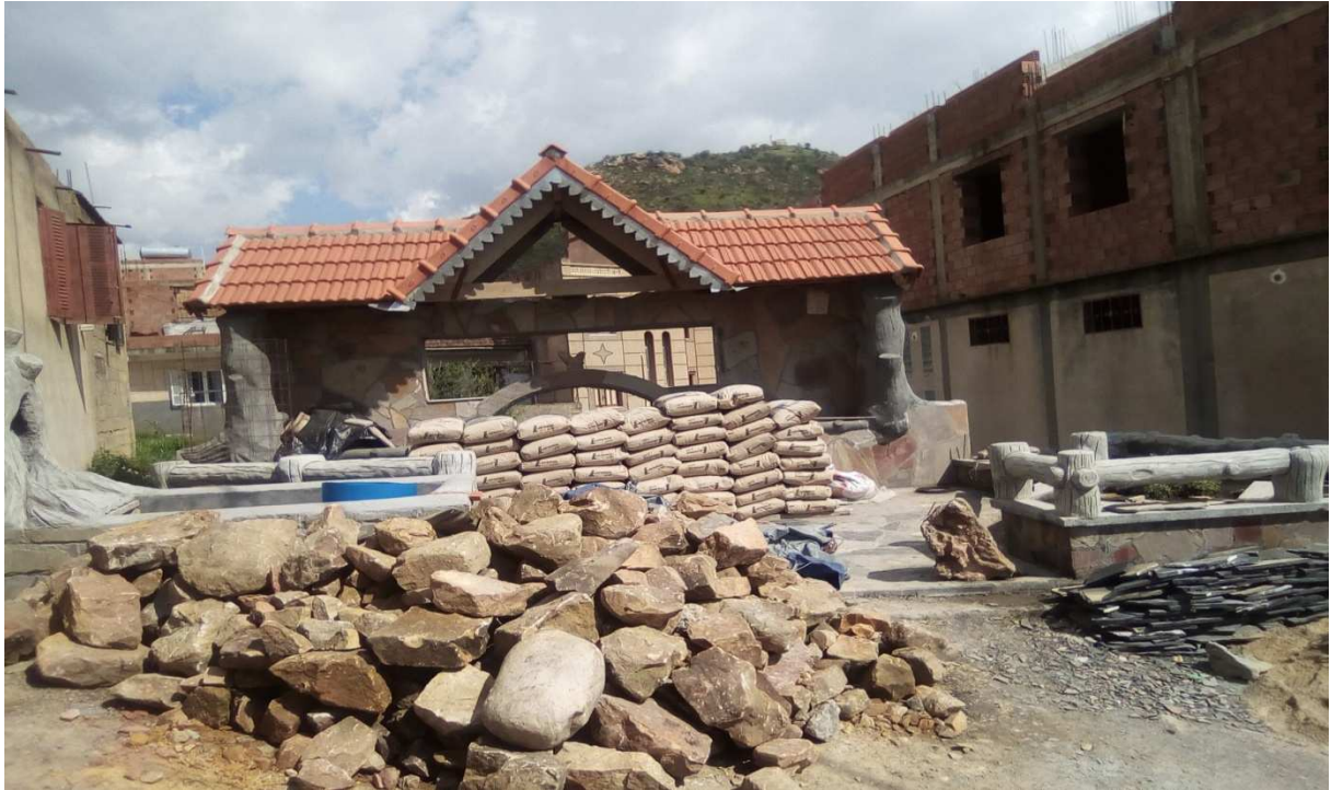
Une fontaine en cours de réhabilitation
