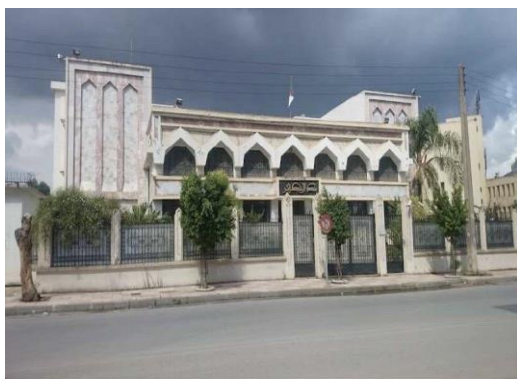
Figure 152:la banque avant la requalification Source : prise par l'auteur
