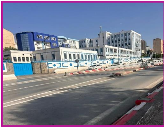
Figure 145: l'entrée du périmètre avant la requalification
