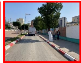
Photo représente l'aménagement des voies prise par l'auteur Date 04/11/24
