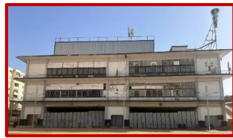
Figure 52: Photo de l'immeuble ancienne gare Source : prise par l'auteur Date 04/11/24
