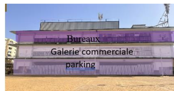
Figure 73: étage bâtiment ancienne gare Source : auteures
