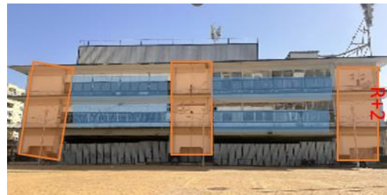
Figure 71: bâtiment ancienne gare Source : traiter par auteures
