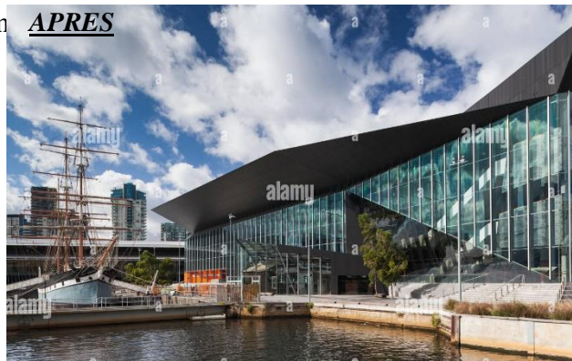
Figure 124:le musée maritime après la réhabilitation Source :Istock
