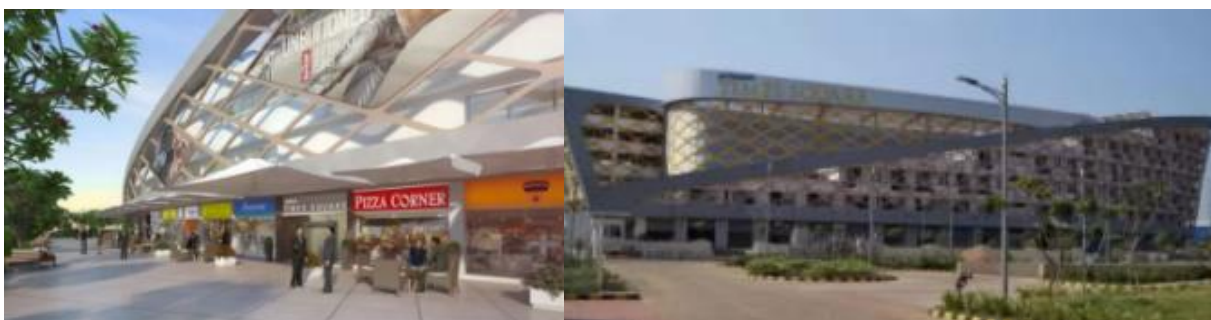
Figure 170: façade de time square mal Source : Pinterest
