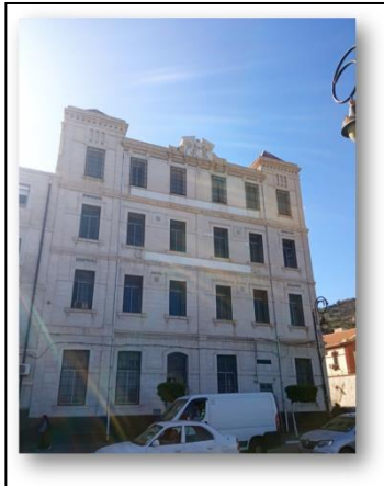
Figure 22 : Façade en bon état Source : photo prise par auteurs
