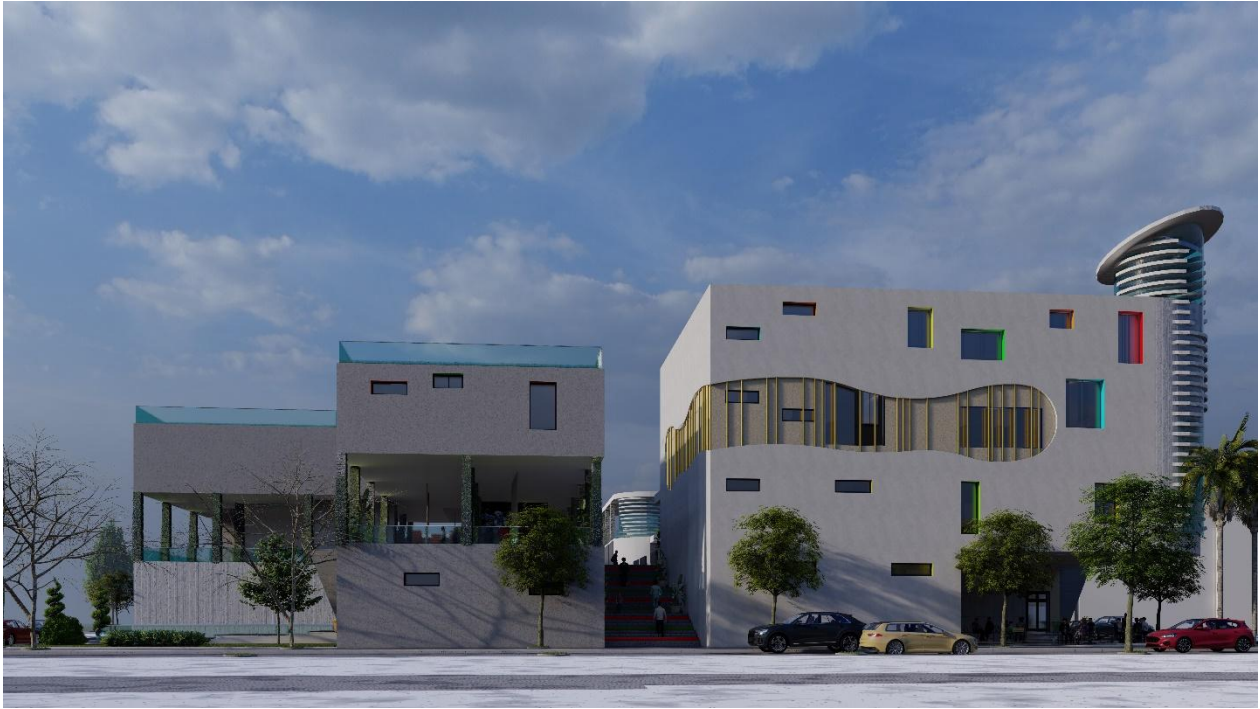
VUE SUR LA FACADE POSTÉRIEURE
