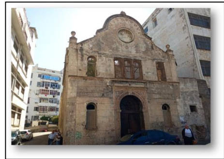
Figure 20: façade de la synagogue Source : photo prise par auteurs
