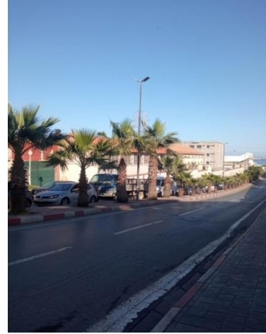
Figure 9: le boulevard Saïd Touati Source: prise par auteurs
