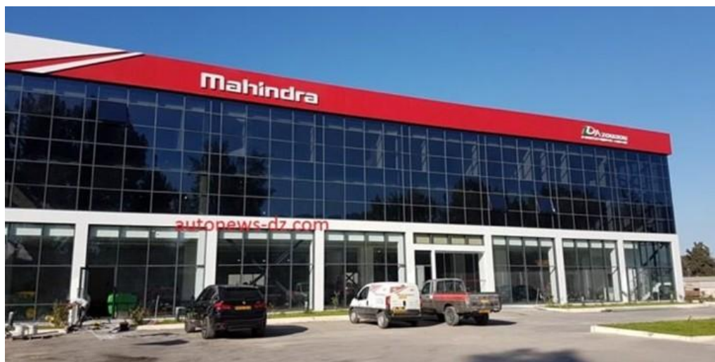
Figure I-1 : Siège de l'entreprise LD AZOUAOU MAHINDRA.
