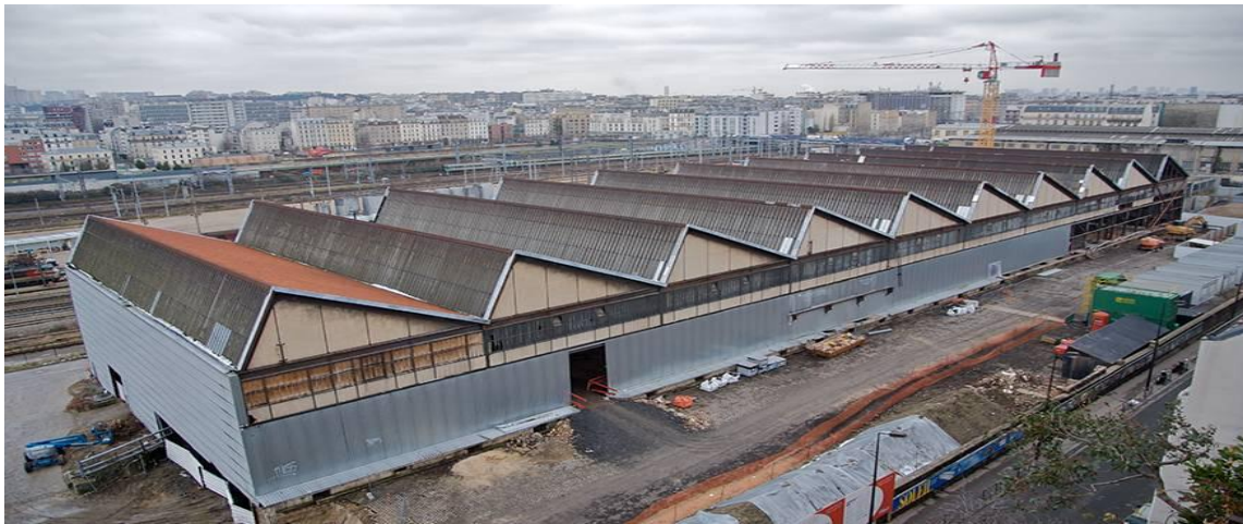
Figure 4 : Photo 1 de l'entrepôt avant les travaux – Source : https://www.la-croix.com/Culture/Voyages/La-Halle-Pajol-une-oasis-ecologique-au-caeur-de-Paris-2015-07-31-1340037 .
