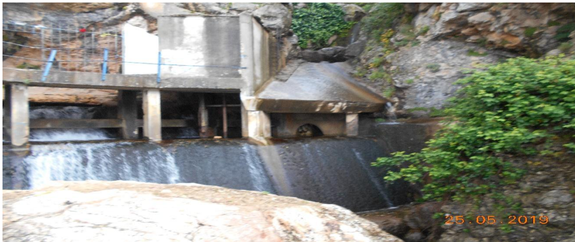
Figure 25 : Centrale hydro-électrique de Boghni : Vue sur la Bâche à eau couverte-Source : Auteur
