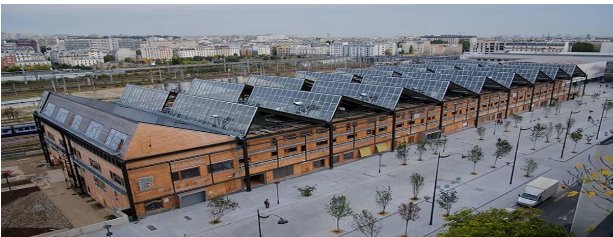
Figure 8 : Photo 5 de l'entrepôt : fin des travaux
