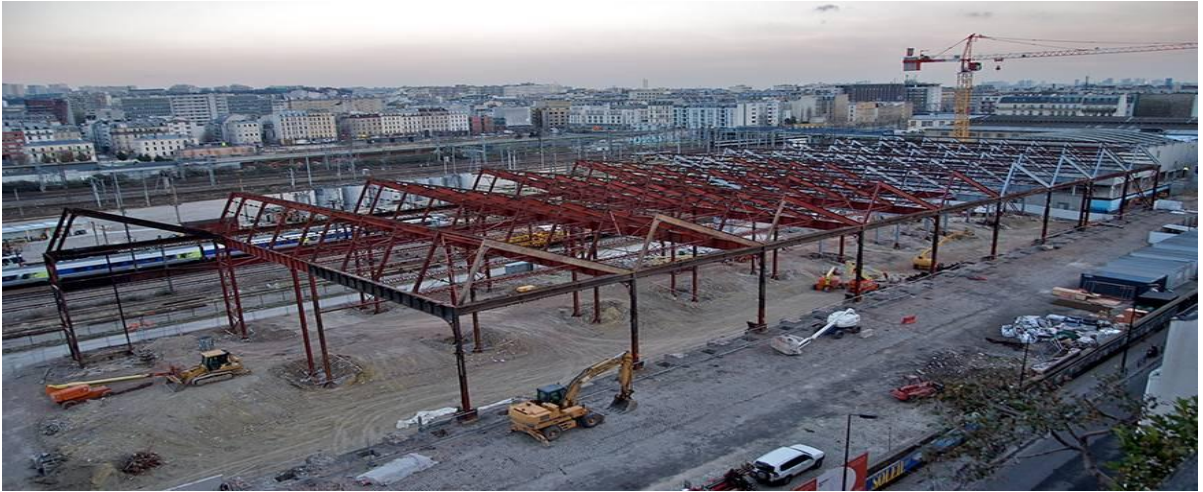
Figure 6 : Photo 3 de l'entrepôt : Démarrage des travaux : Démontage du toit et parois
