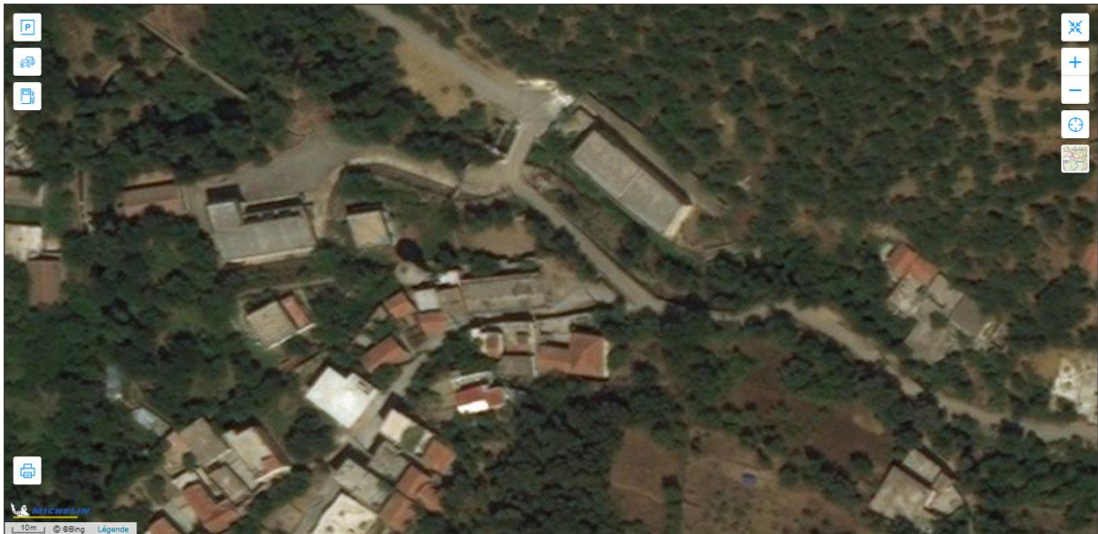
Figure 40 : Centrale Hydro-électrique - Photo satellitaire de source Google map
