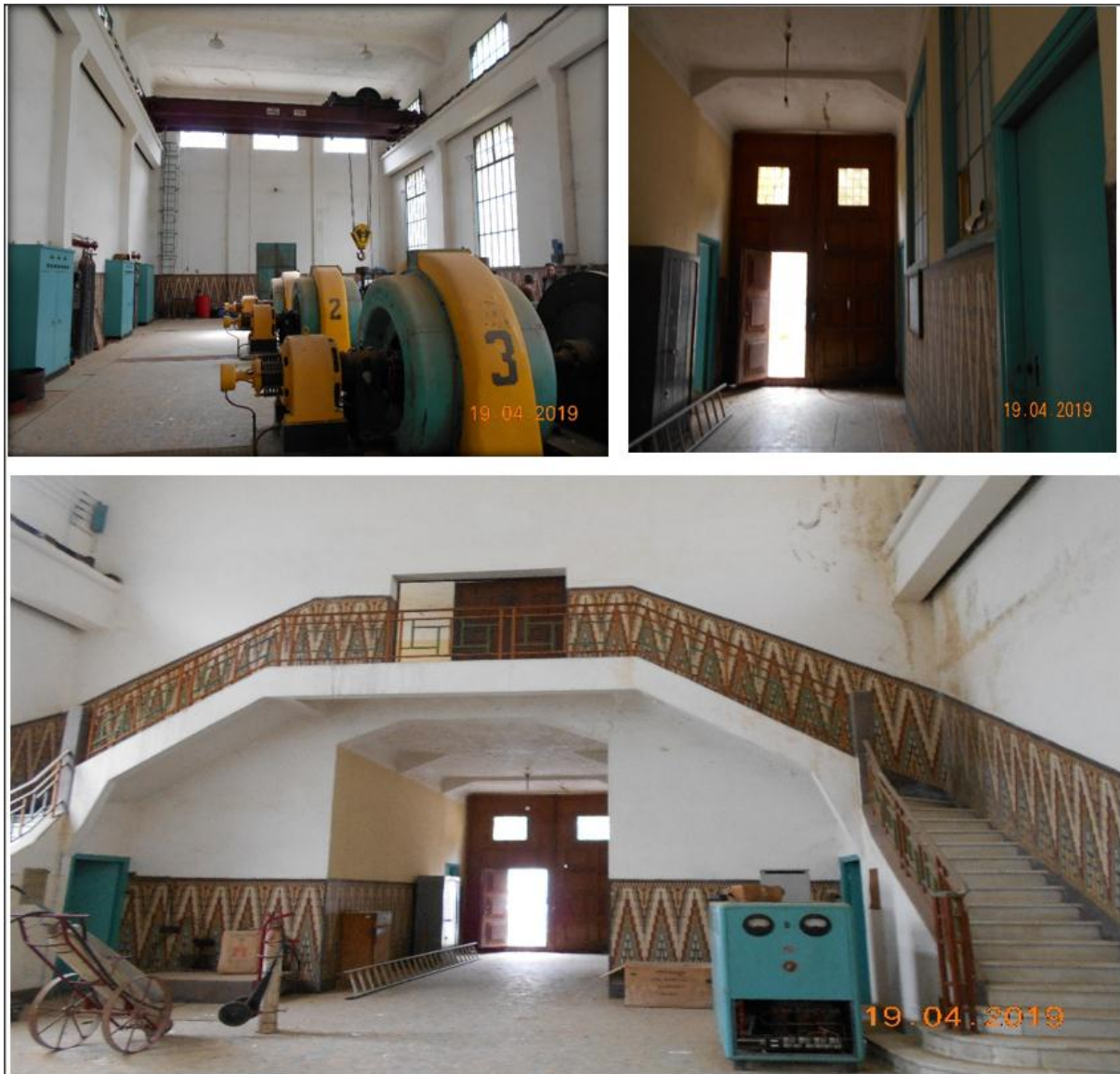
Figure 43 : Quelques photo de l'intérieur de l'Usine. Source : Auteur.
