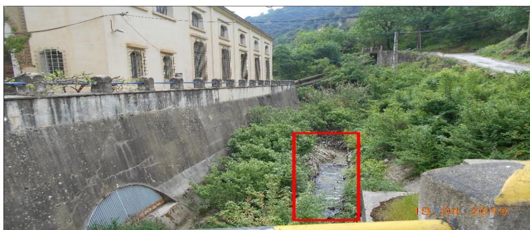
Figure 36 : Centrale Hydro-électrique : Vue sur le lit de l'Oued Source Auteur – 2019
