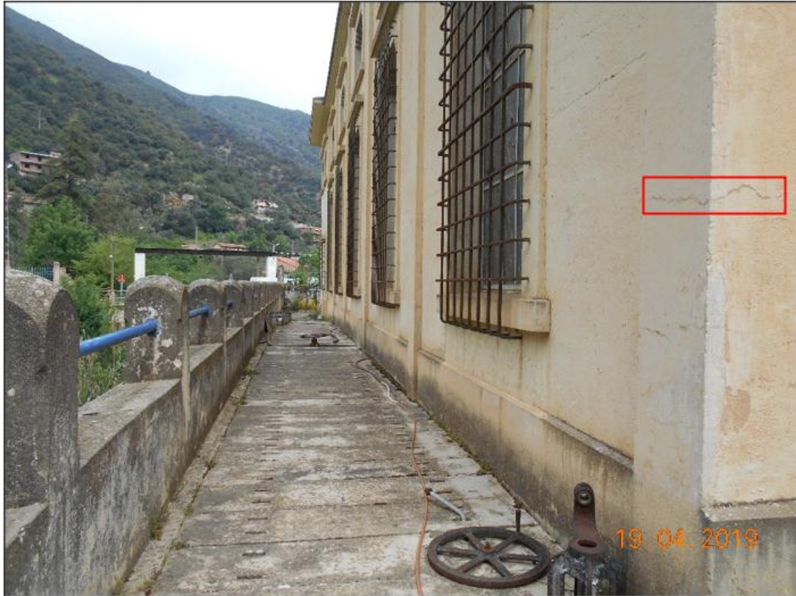
Figure 71 : Fissure superficielle
