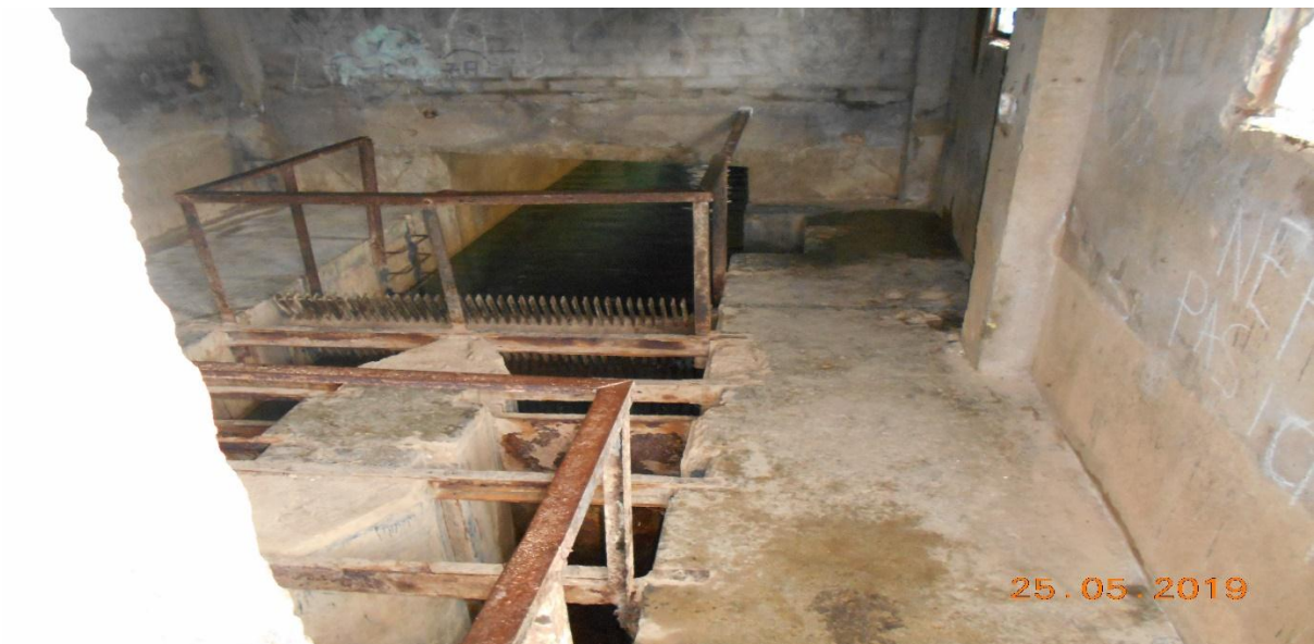
Figure 29: Centrale hydro-électrique de Boghni : Vue de l'intérieur de la bâche de captage à l'état actuel-Source : Auteur
