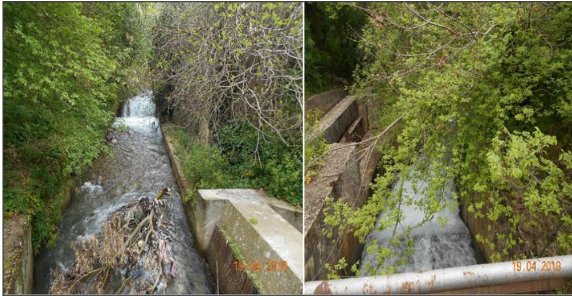
Figure 80: Deux photos de murs de soutènement protecteurs des installations
