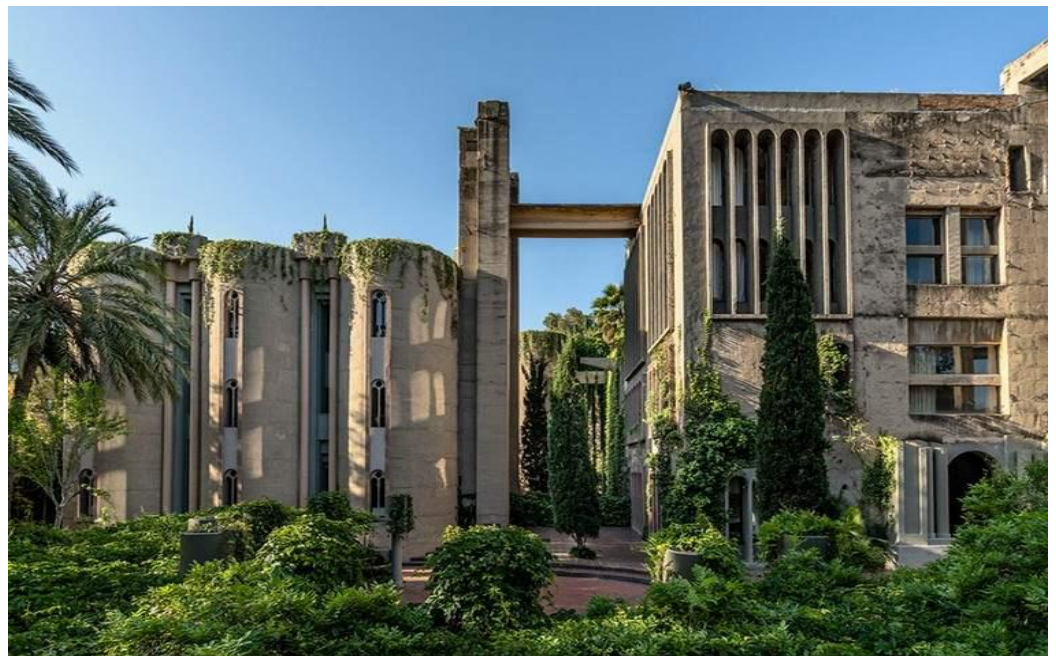
Figure 14 : Photo 5 de la Fabrice de Barcelona : Vue de l'extérieur
