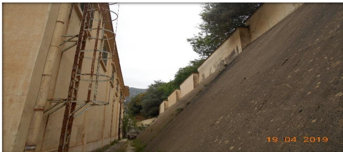
Figure 35 : Centrale Hydro-électrique : Vue sur le mur de soutènement Source Auteur – 2019
