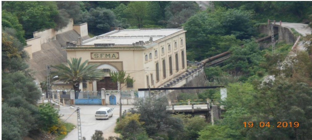
Figure 23 : Station Hydro électrique de Boghni -- Source :auteur.
