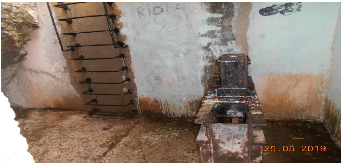
Figure 26: Vue intérieure de la bâche à eau couverte -Source : Auteur
