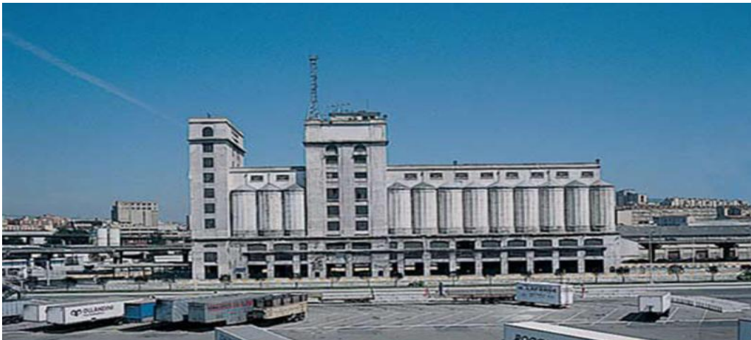
Figure 17 : Photo 1 du Silo de Marseille
