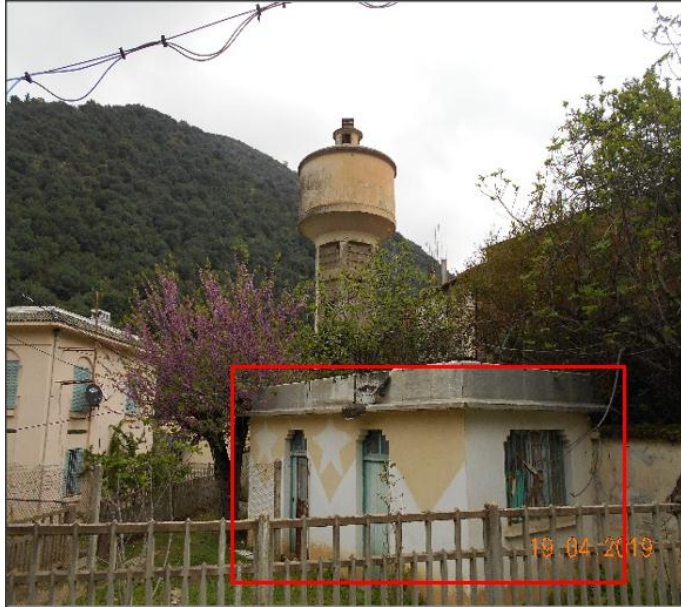
Figure 57 : Vue extérieure sur la Buanderie Source : Auteur
