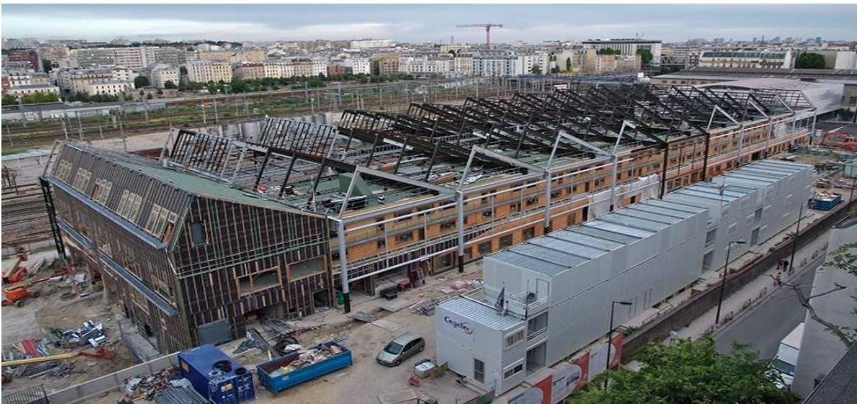
Figure 7 : Photo 4 de l'entrepôt : reconstruction et installation du toit en panneaux solaires
