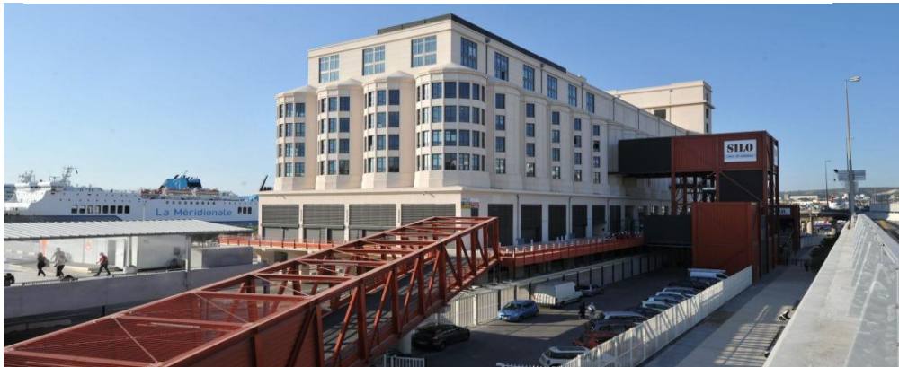
Figure 20 : Photo du SILO de Marseille : Après la fin des travaux
