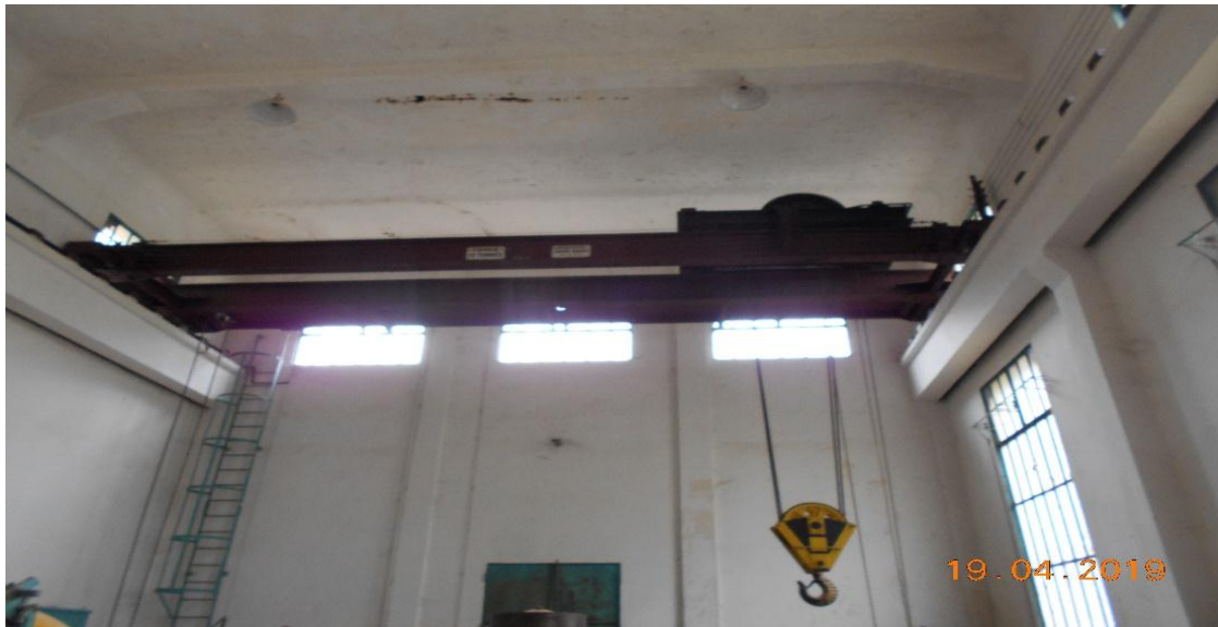
Figure 67 : Système constructif sain dans l'usine Source : Auteur
