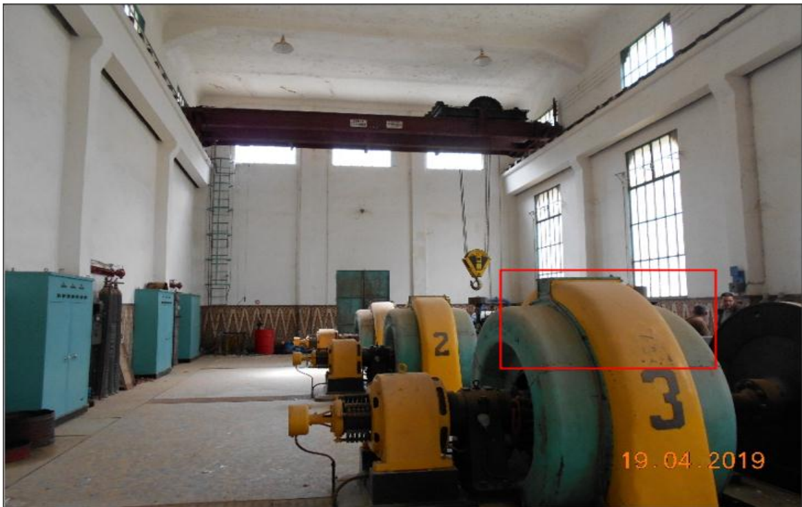
Figure 65 : Traces de poussière dans la salle de distribution Source : Auteur
