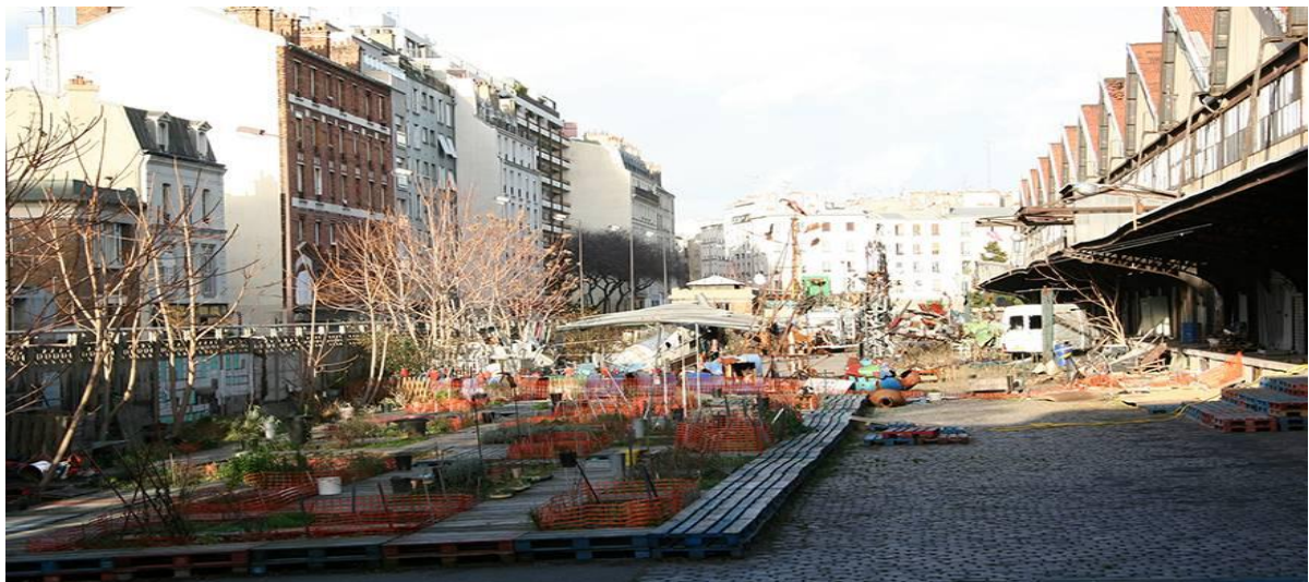
Figure 5 : Photo 2 de l'entrepôt – Vue sur la cour.
