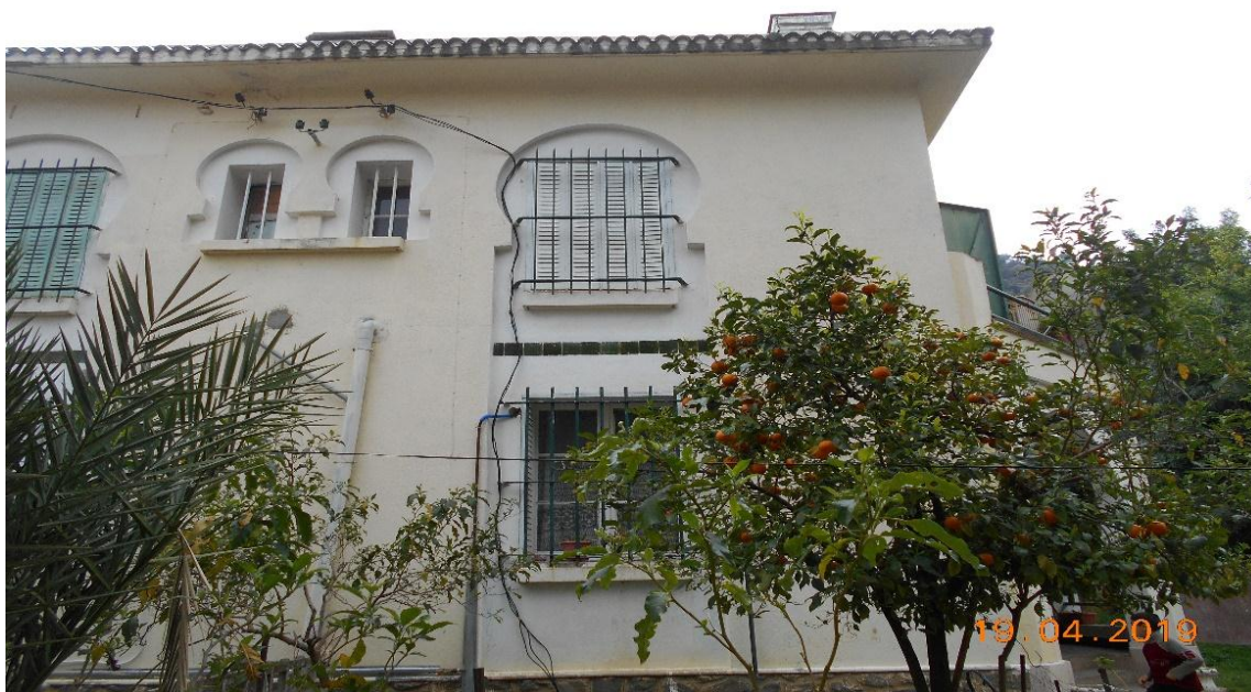
Figure 52 : vue extérieure de la maison du contre maitre
