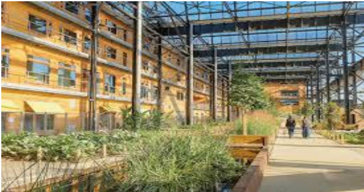
Figure 10 : Photo 7 de l'entrepôt : Vue sur l'intérieur de l'oasis
