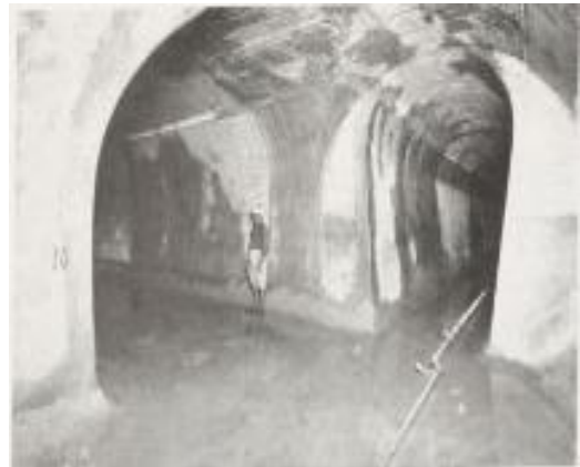
Figure 32 : Centrale hydro-électrique de Boghni : Vue sur les galeries d'accumulation et le sous terrain après la fin des travaux Source : Chantier, revue mensuelle
