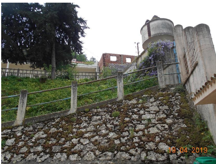
Figure 56 : Vue sur la bâche à eau Source : Auteur
