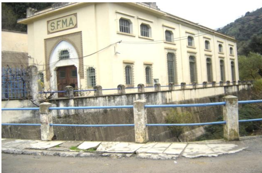
Figure 1: Photo de la centrale hydrolique de BOGHNI, Source : Auteur – 2019.
