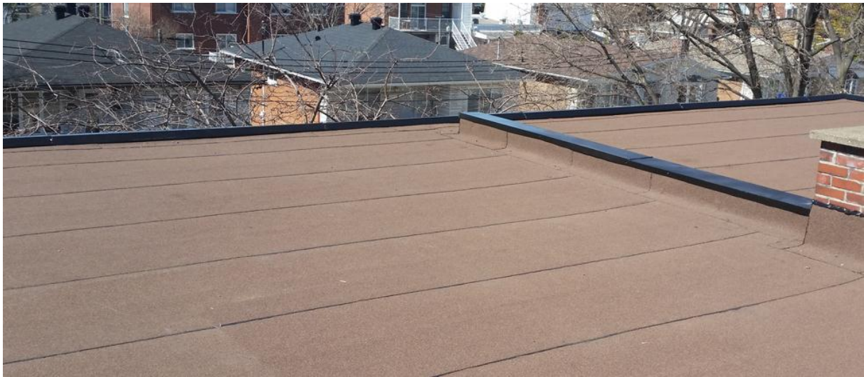
Figure 76: Photo d'une terrasse à base de membrane
