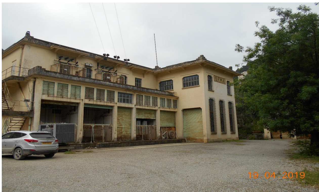
Figure 49 : Vue sur la cour de la partie distribution Source : Auteur
