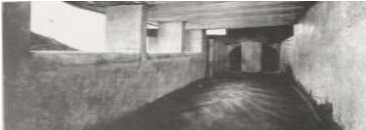
Figure 28 : Centrale Hydro-électrique de Boghni : Vue de l'intérieur de la bâche de captage – Source : Chantier, revue mensuelle.
