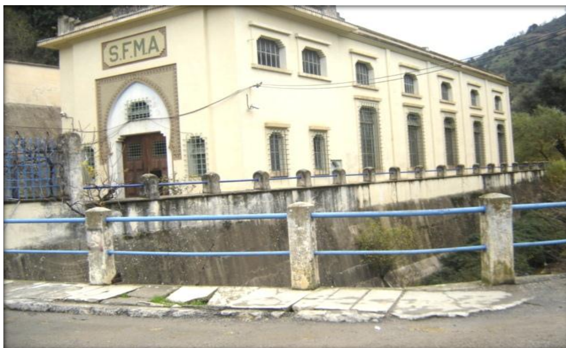
Figure 37 : Centrale Hydro-électrique : Vue sur l'usine Source Auteur – 2019
