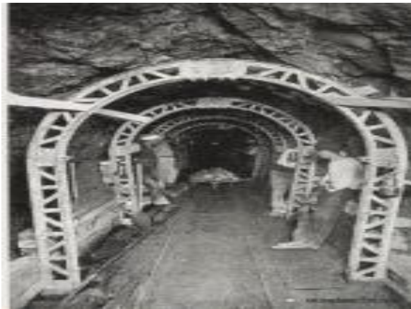
Figure 31 : Centrale hydro-électrique de Boghni : Vue sur le sous Terrain en réalisation. Source : Chantier, revue mensuelle
