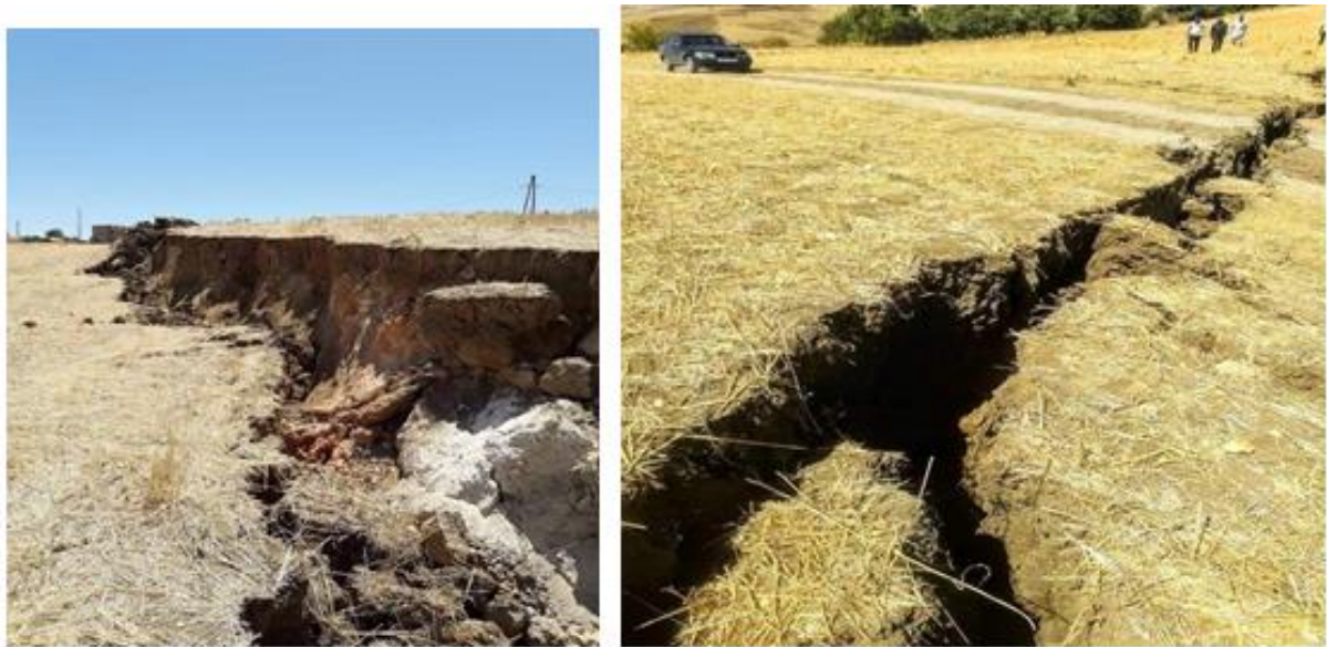
Figure 38 : deux photos qui montre le glissement de terrain de Mila. (journal al Watan)
