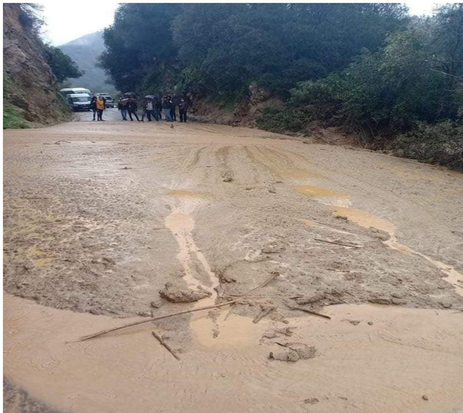
Figure 18 : coulée de Boue sur la RN15 vers Bouira.
